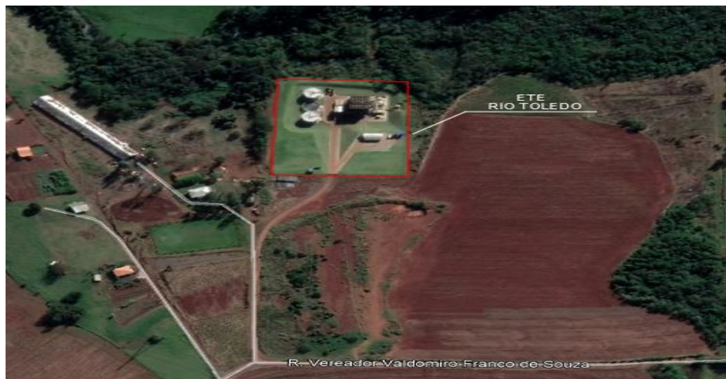
Figura 11 – Localização da ETE Rio Toledo (Latitude 24°45'16" S e Longitude 53°45'28"W)
