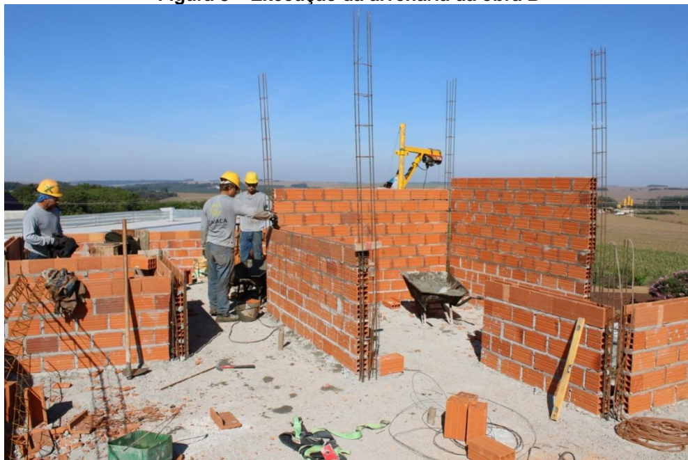
Figura 8 – Execução da alvenaria da obra B
