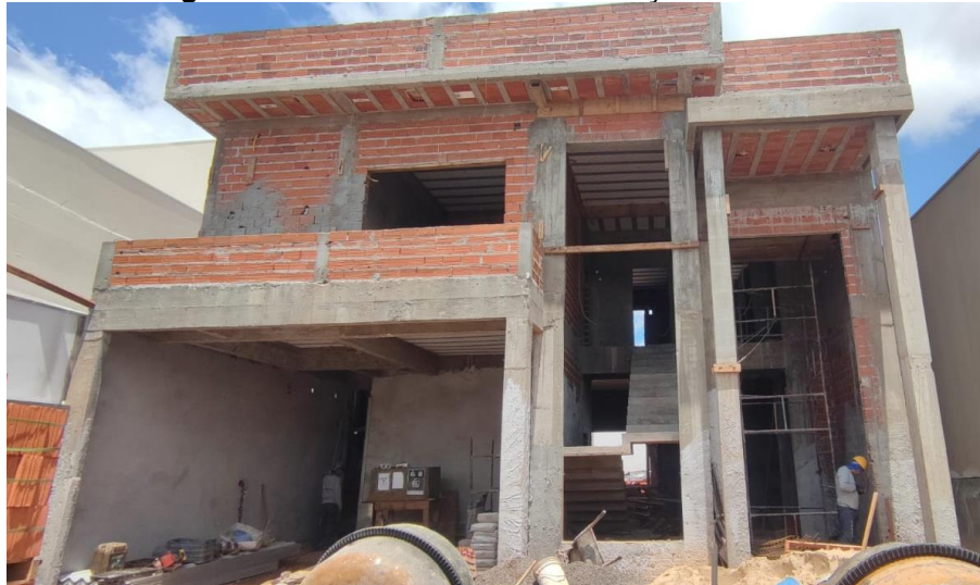
Figura 7 – Fachada durante a execução da Obra C
