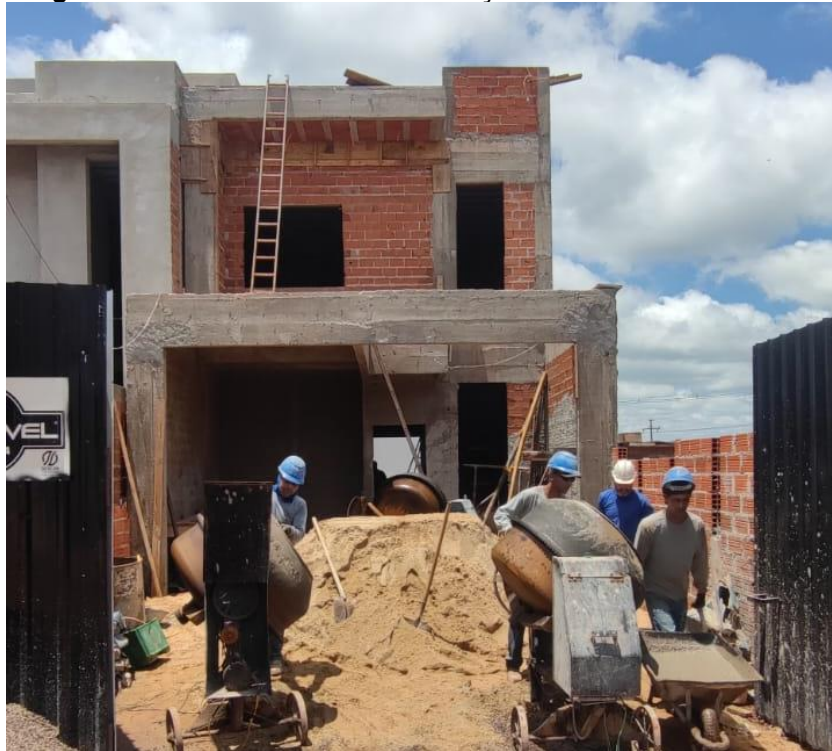
Figura 5 – Fachada durante a execução da obra B - unidade 02
