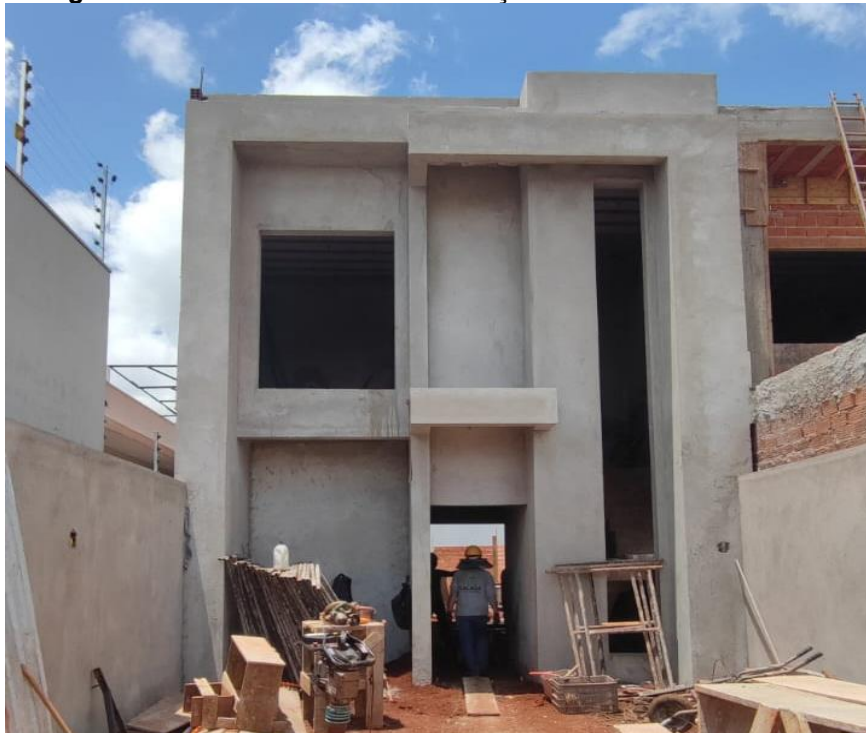
Figura 4 – Fachada durante a execução da obra B - unidade 01
