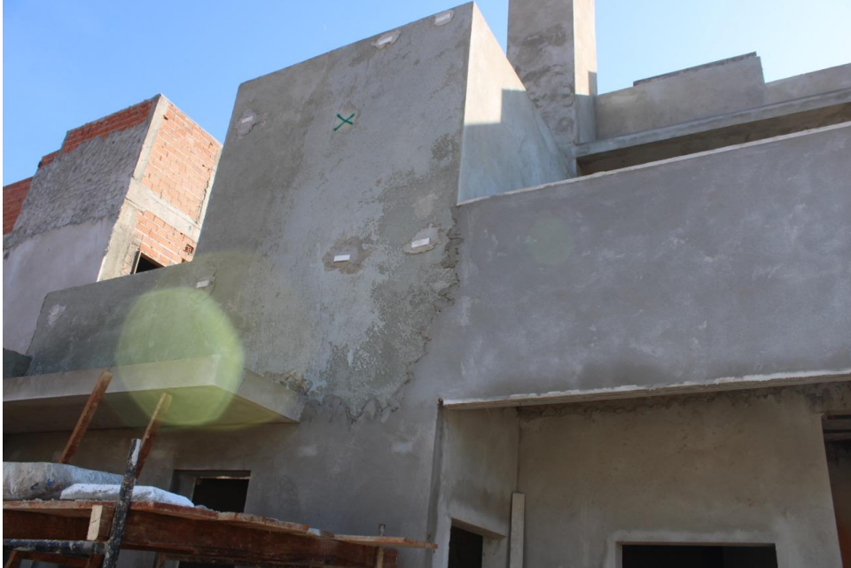
Figura 10 - Demarcação do reboco
