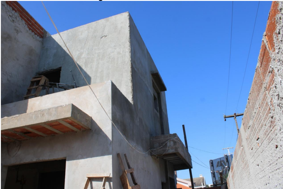
Figura 11 – Reboco externo
