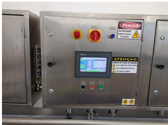
Figura 41 – Construção do painel elétrico - externo
