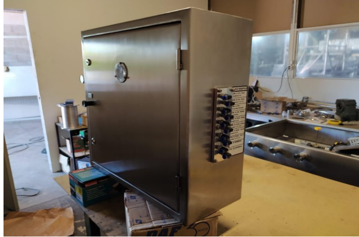
Figura 44 – Construção do painel pneumático - externo
