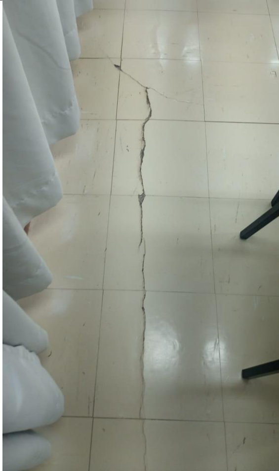
Figura 11: Fissura em laje cobertura Bloco Q – Anomalia 16
