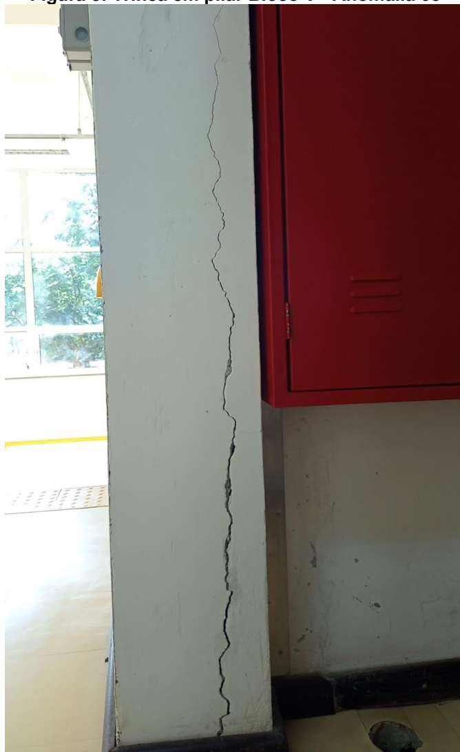
Figura 8: Trinca em pilar Bloco V - Anomalia 08
