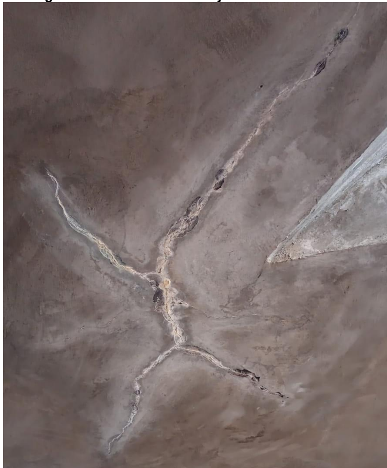
Figura 6: Eflorescência em laje Bloco B – Anomalia 46
