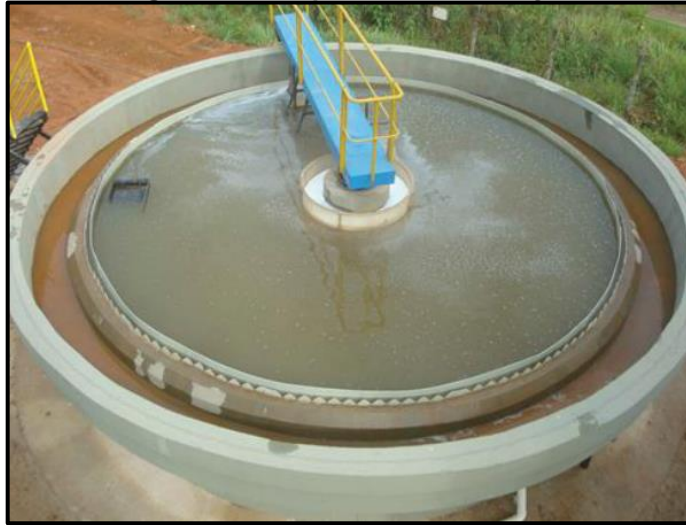
Figura 4 – Tanque de Sedimentação
