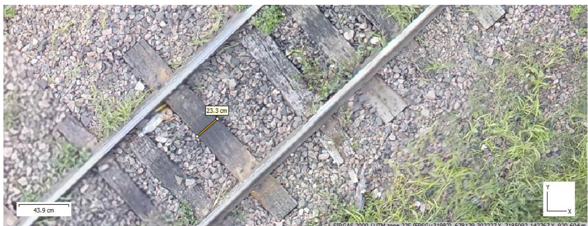
Figura 40 - Medição da largura do dormente
