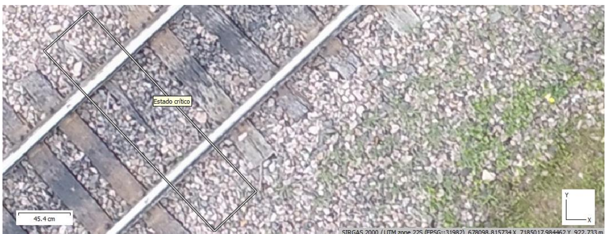
Figura 45 - Dormente em estado de deterioração avançada
