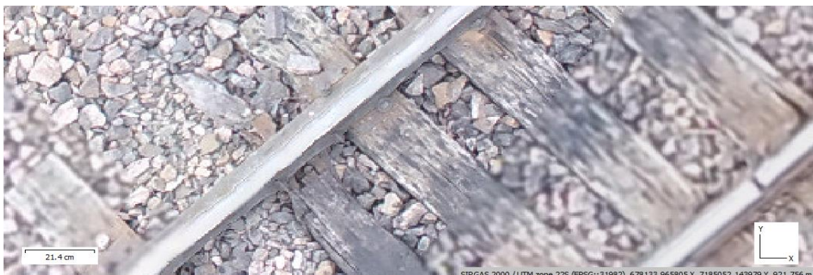
Figura 46 - Dormente sem zona de fixação
