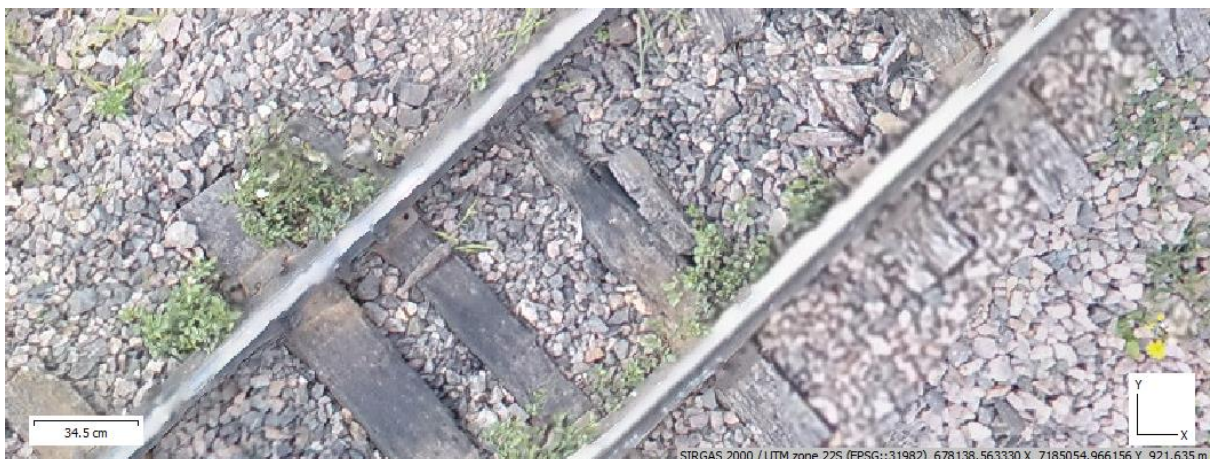
Figura 48 - Dormente sem zona de fixação
