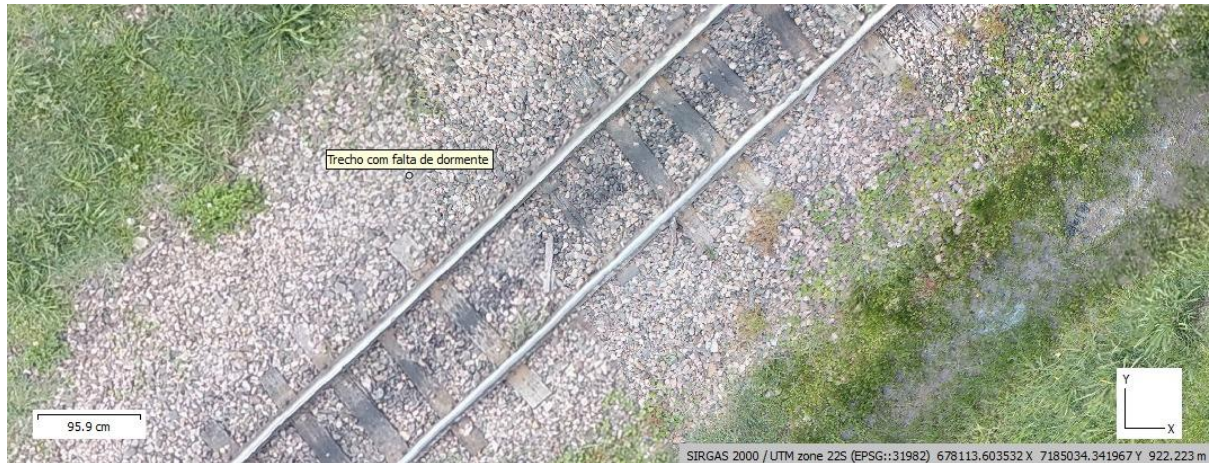
Figura 42 – Trecho com sequência de dormentes ausentes
