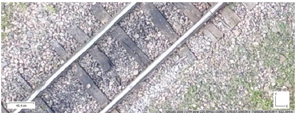
Figura 47 - Dormente com geometria faltante
