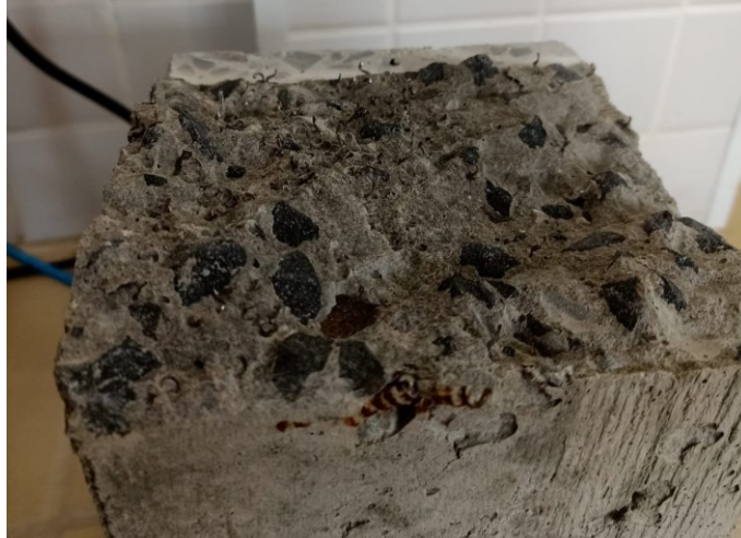
Fotografia 14 - Ruptura do concreto com cavaco tubular
