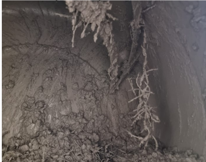
Fotografia 6 - Formação de ouriço no concreto com cavaco tubular
