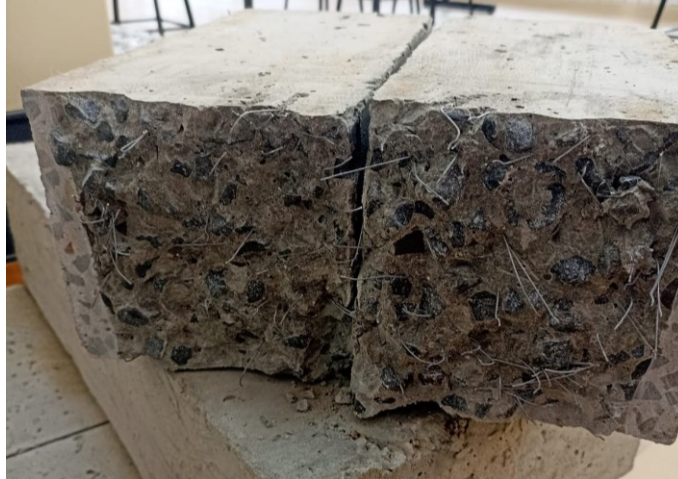
Fotografia 13 - Ruptura do concreto com fibra de aço
