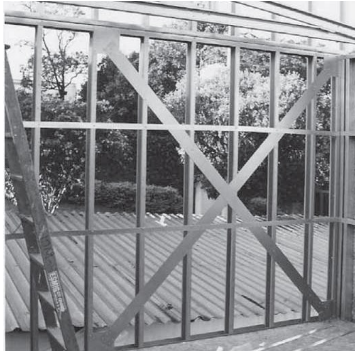
Figura 7 - Painel com contraventamento em “X”.
