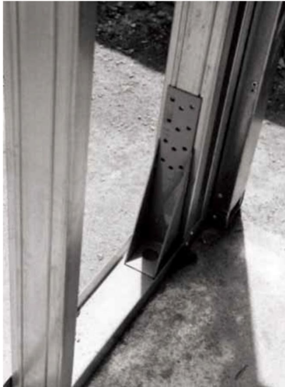
Figura 9 - Conector de ancoragem com barra roscada “hold-down”.
