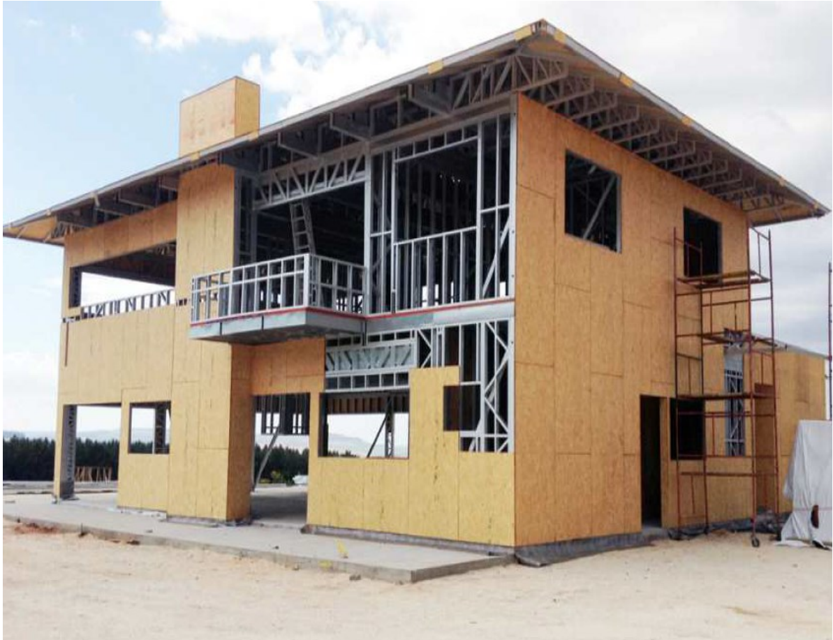
Figura 2 - Edificação com fechamento externo em placas de OSB.
