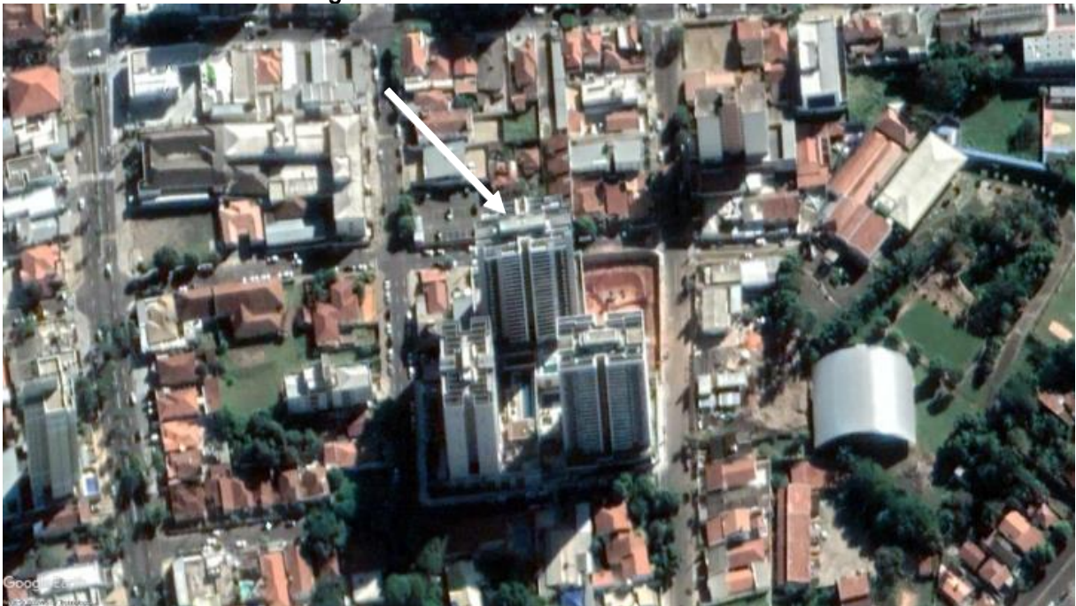
Figura 7 – Edifício residencial em estudo.
