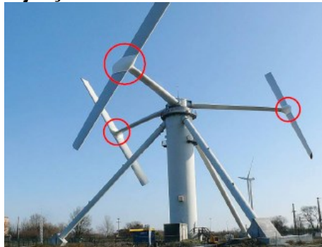
Figura 8 - Exemplo de junções carenadas na turbina Nénuphar-Wind 600 kW
