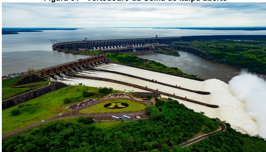
Figura 01 - Vertedouro da Usina de Itaipu aberto
