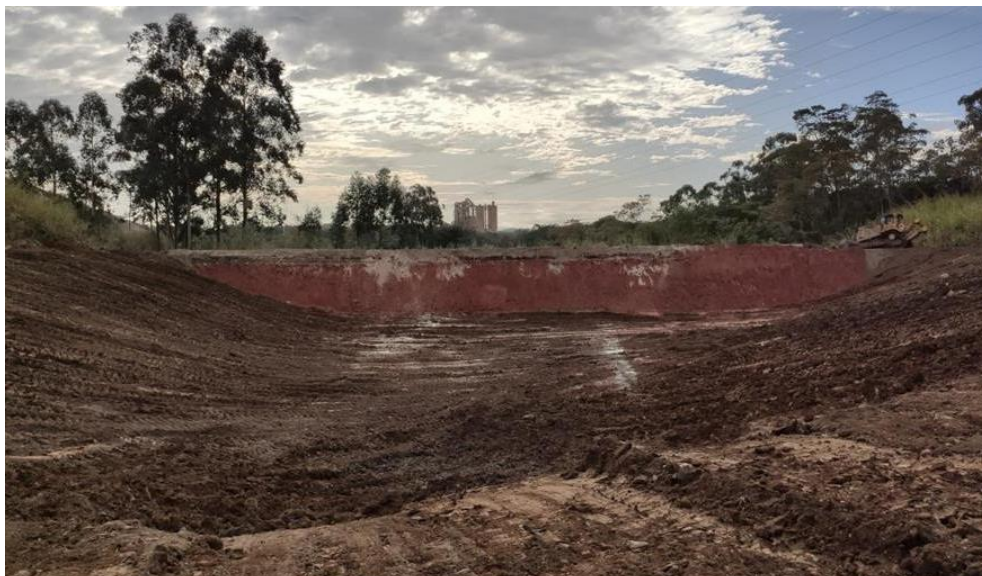
Figura 4. Área objeto do projeto detalhe região solo exposto após descomissionamento da manta de impermeabilização
