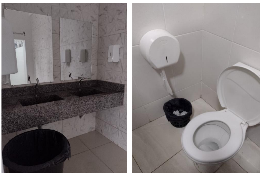
Figura 17 – Detalhes do interior do banheiros feminino.
