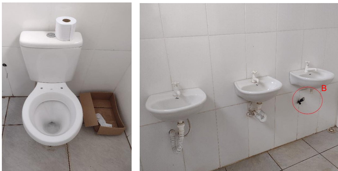
Figura 8 - Imagens do interior do banheiro feminino do Parque Alvorada.
