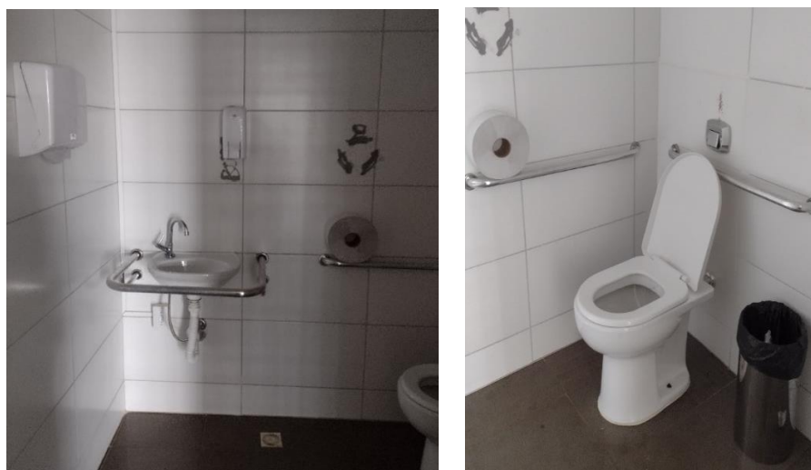
Figura 22 - Interior do banheiro feminino para pessoas com mobilidade reduzida.
