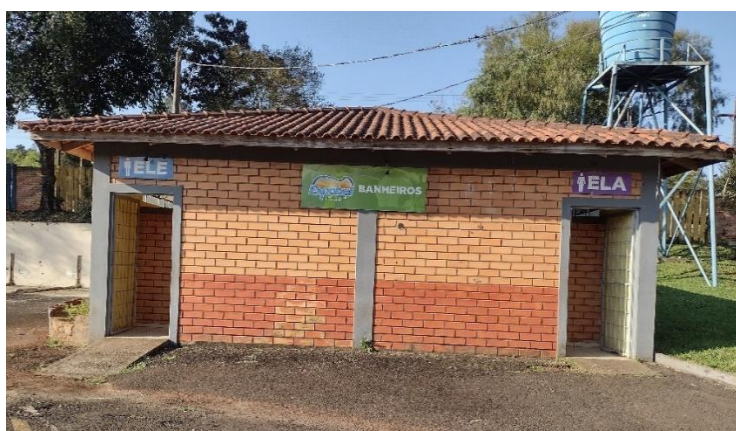
Figura 10 - Entrada para os segundos banheiros com identificação de gênero.
