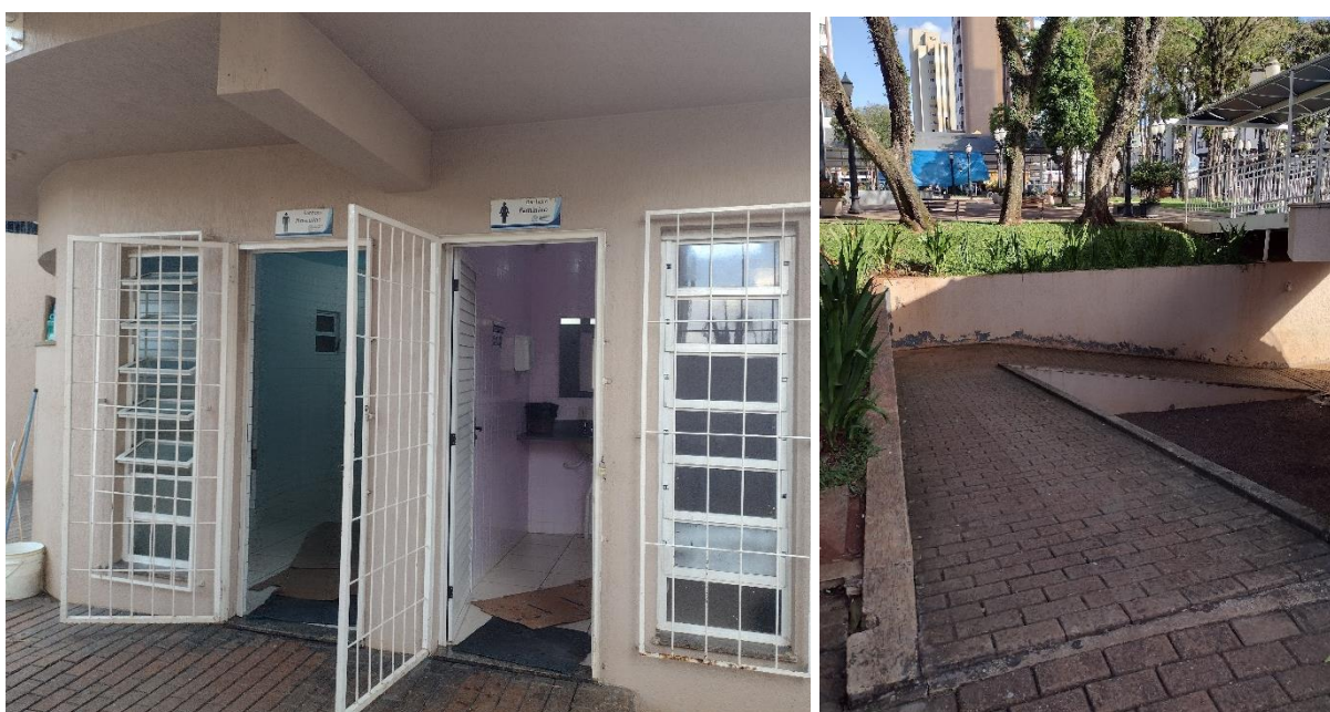
Figura 13 - Entrada dos banheiros da Praça Central.
