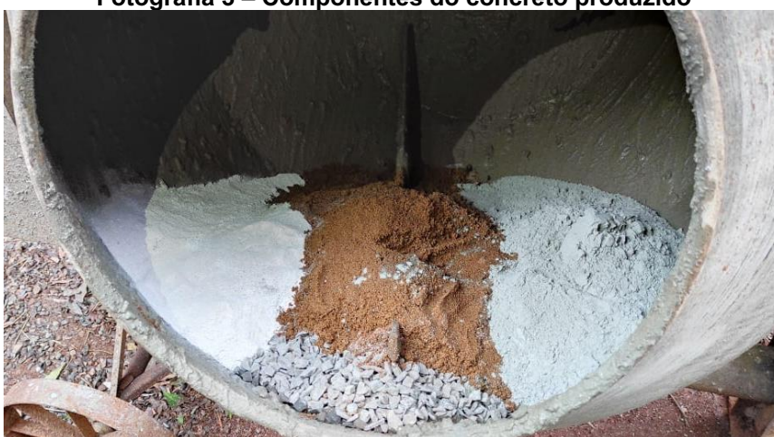
Fotografia 3 – Componentes do concreto produzido
