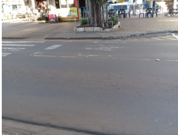
Figura 24 - Sinalização deteriorada Av. Capitão Índio Bandeira com a Rua Harrison José Borges
