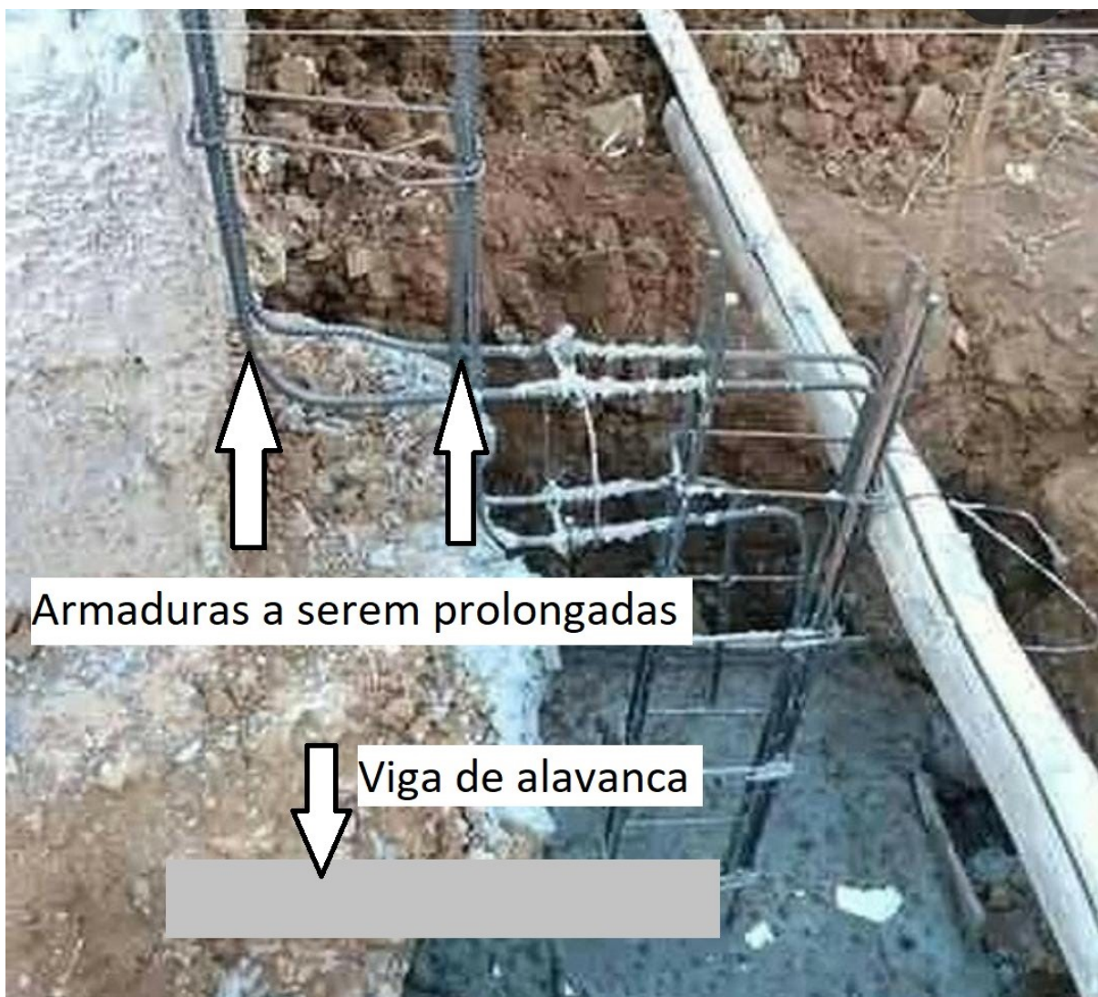
Figura 12 – Viga de alavanca.
