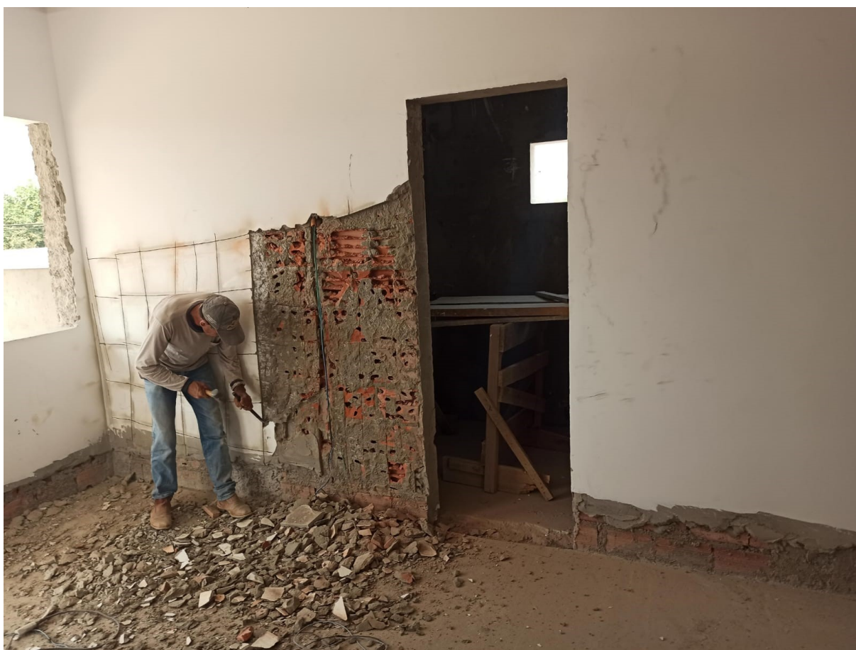
Figura 9 – Emboço sendo refeito.
