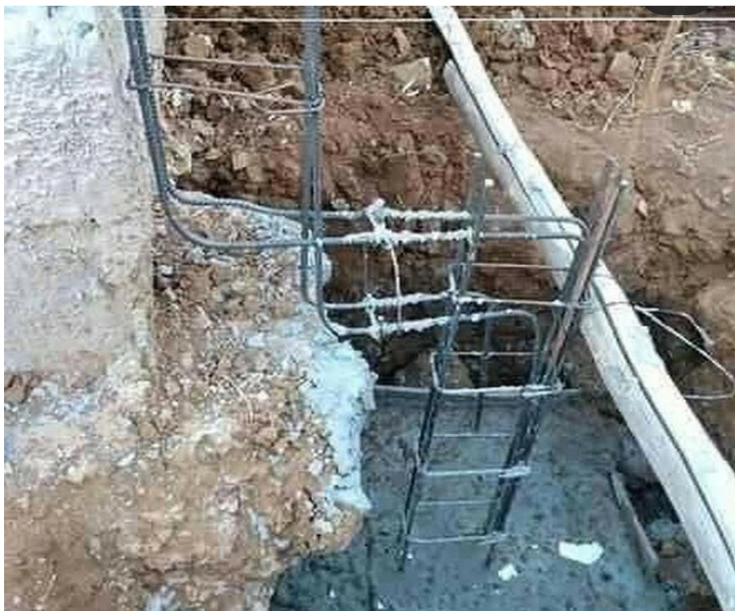
Figura 11 – Excentricidade em pilar
