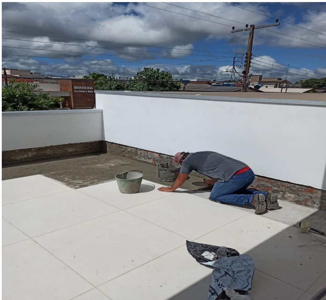
Figura 20 – Laje sendo impermeabilizada.
