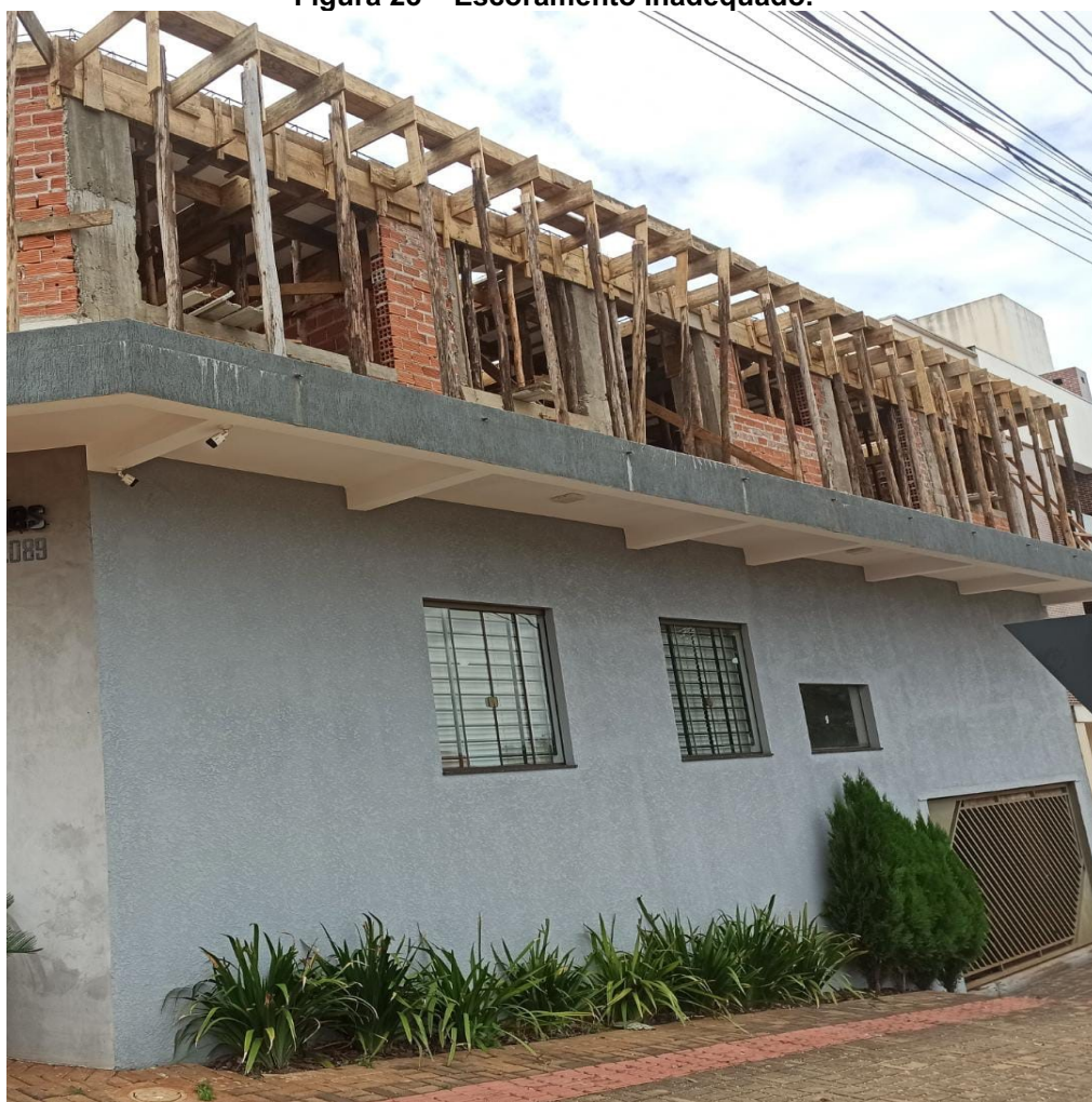
Figura 23 – Escoramento Inadequado.
