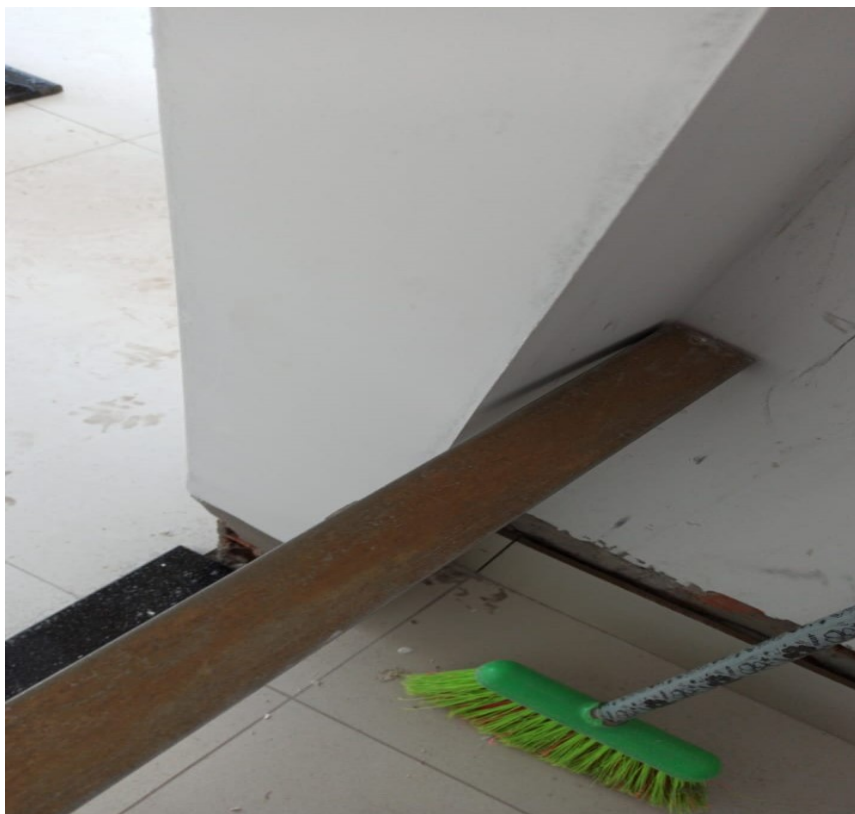
Figura 8 – Alvenaria irregular
