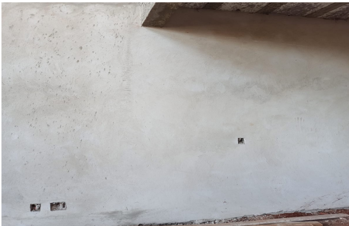
Figura 33 – Alvenaria e pilar consertados.
