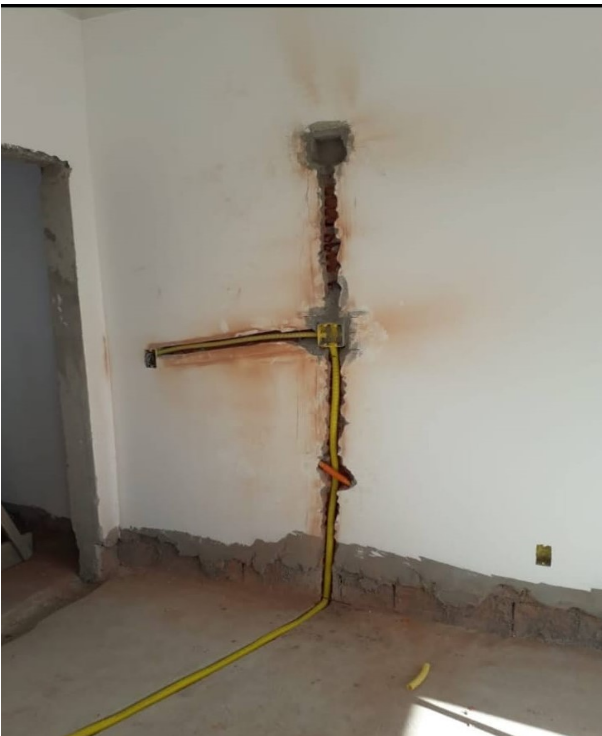
Figura 27 – Instalações sendo refeitas.
