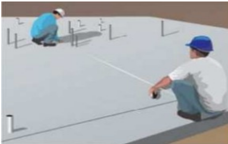
Figura 5 – Esquema ilustrativo da locação de elementos estruturais na fôrma da laje com o auxílio de trenas e lápis de carpinteiro.
