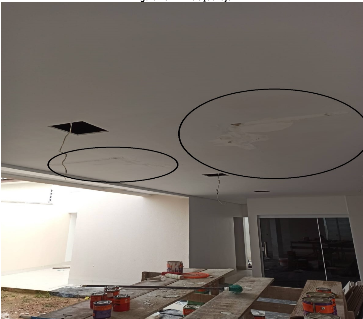
Figura 19 – Infiltração laje.
