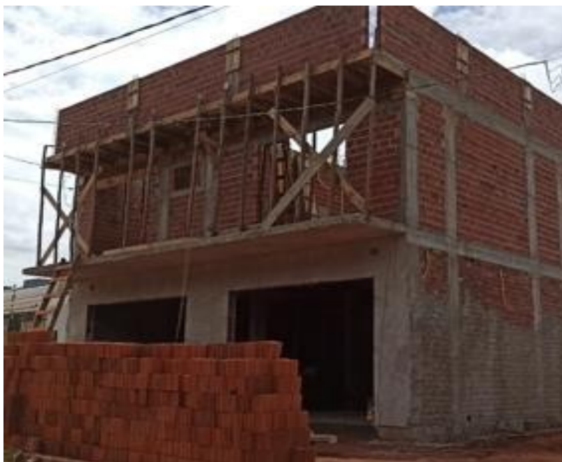
Figura 22 – Escoramento Inadequado.
