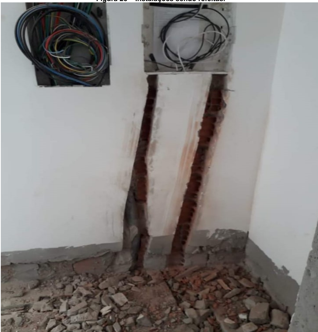
Figura 28 – Instalações sendo refeitas.
