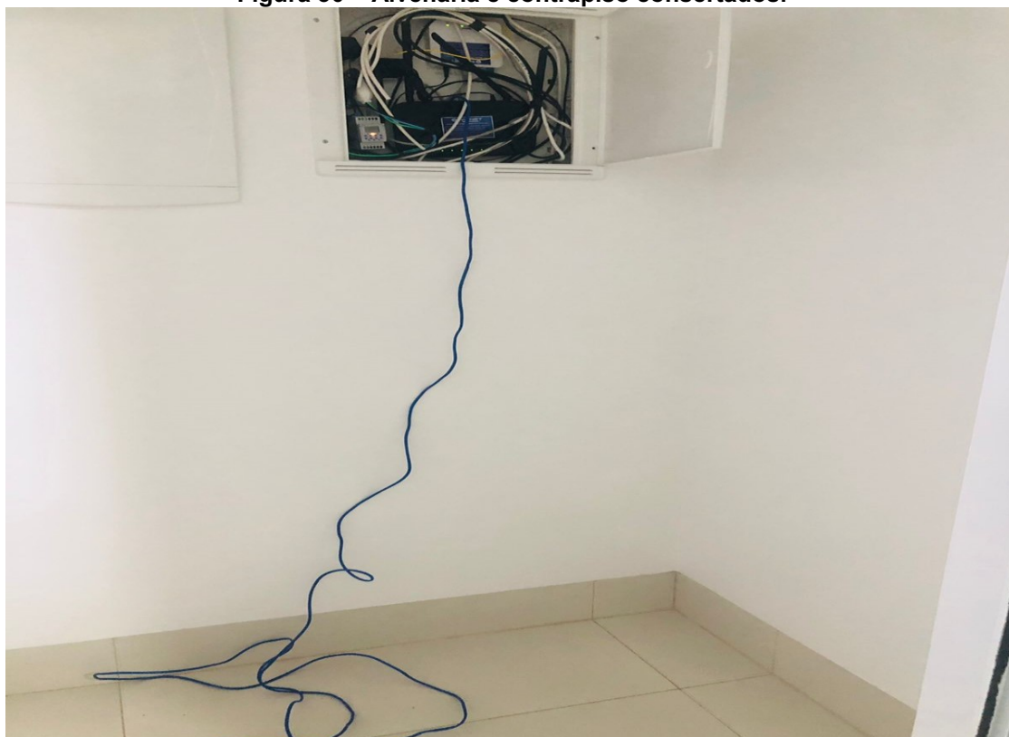
Figura 30 – Alvenaria e contrapiso consertados.
