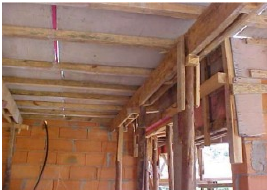
Figura 7 – Escoramento com madeira.
