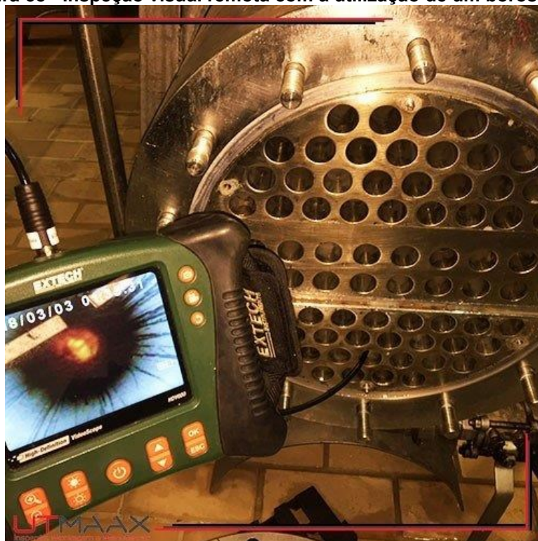
Figura 58 - Inspeção visual remota com a utilização de um boroscópio
