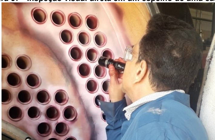
Figura 57 - Inspeção visual direta em um espelho de uma caldeira
