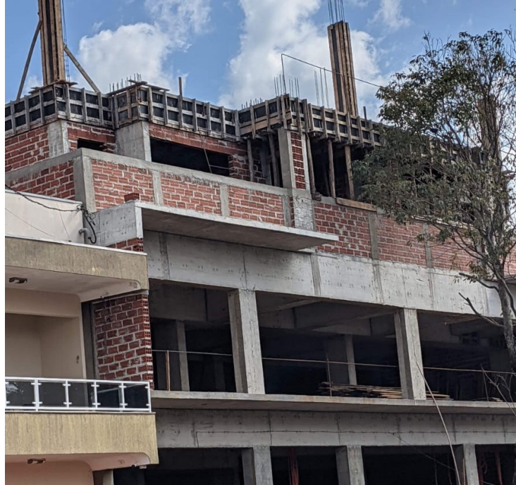
Fotografia 1: Construção com estrutura de concreto armado com alvenaria de vedação
