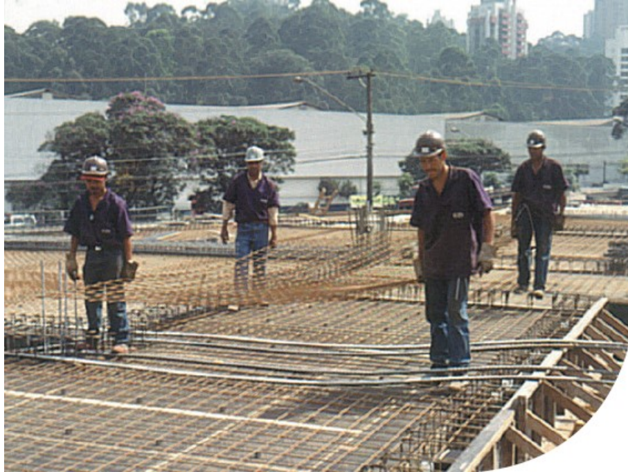
Fotografia 1 - Exemplo de uso da tela metálica
