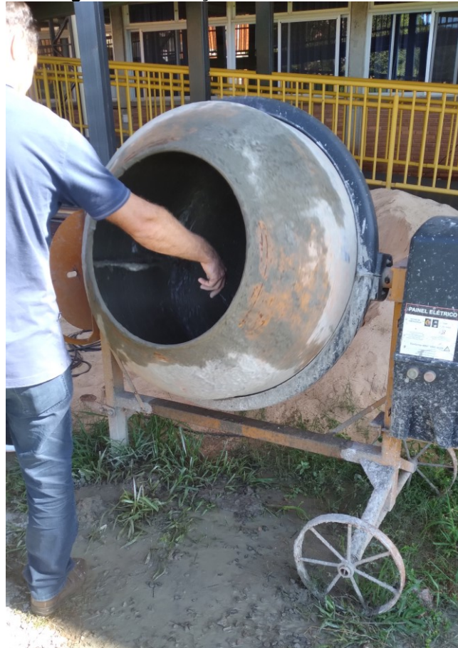
Fotografia 12 – Adição das fibras ao concreto
