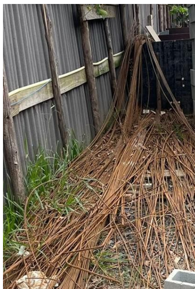
Figura 13 - Armazenamento de barras
