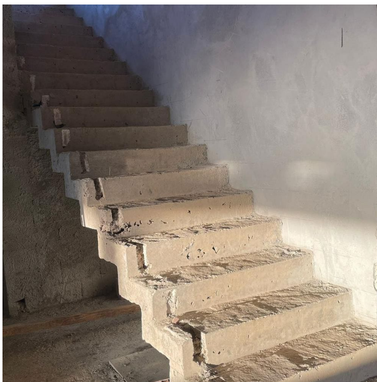
Figura 25 - Escadas de acesso
