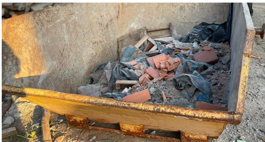
Figura 22 - Armazenamento central de entulhos
