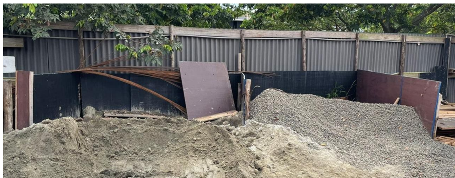
Figura 16 - Armazenamento de areia e brita
