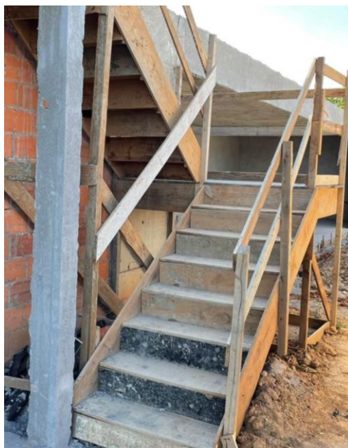
Figura 5 - Escadas de acesso
