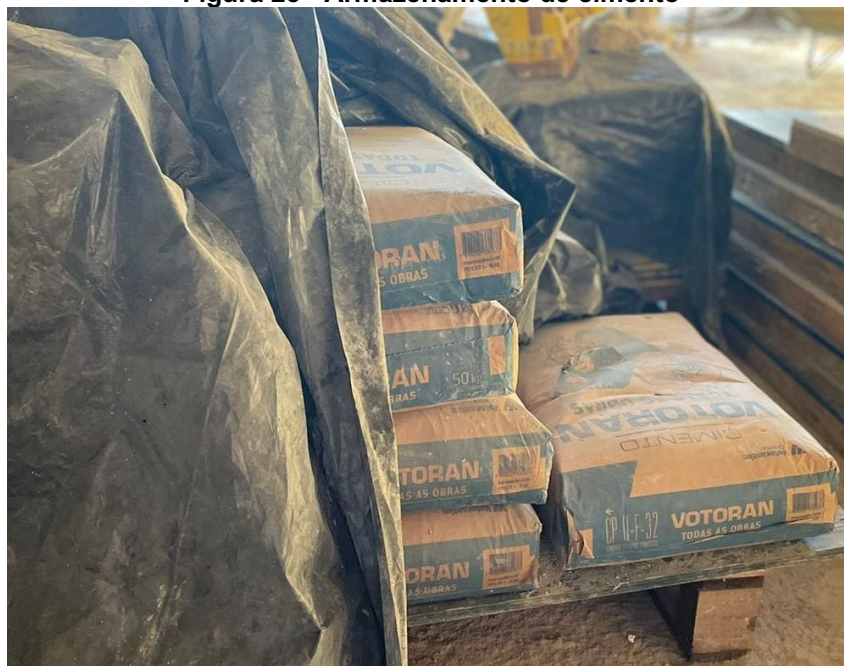
Figura 23 - Armazenamento de cimento
