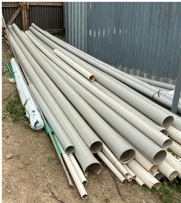
Figura 30 - Armazenamento de tubulação de PVC
