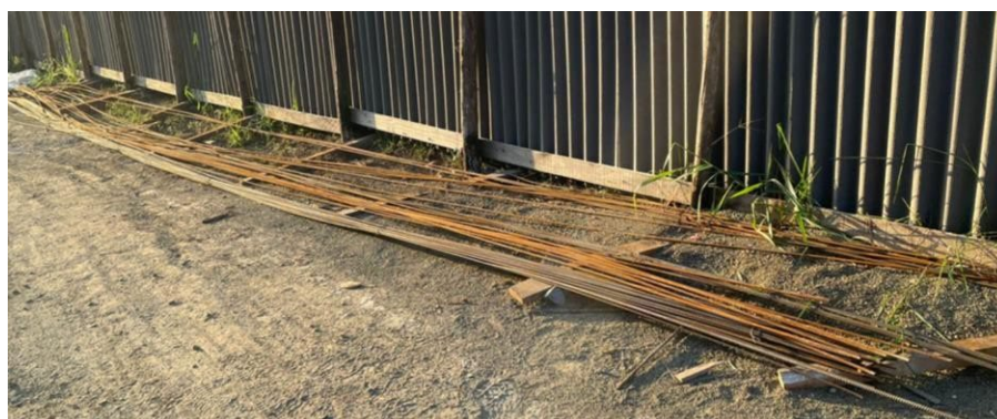
Figura 21 - Armazenamento de barras de aço
