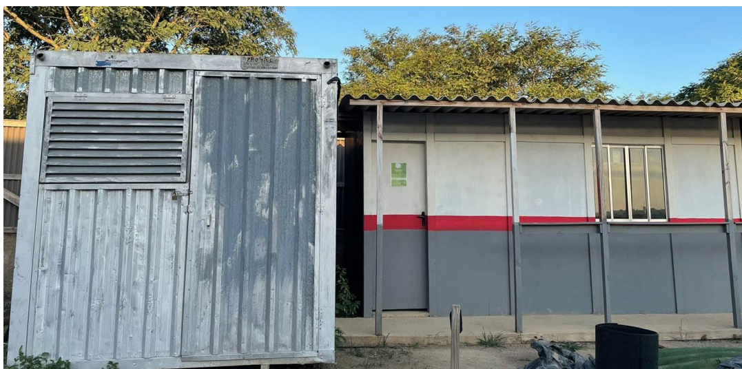
Figura 18 - Almoxarifado e instalações administrativas
