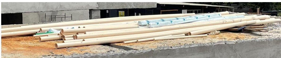
Figura 9 - Armazenamento de tubulação de PVC
