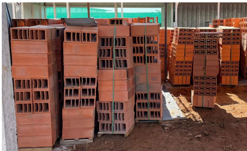
Figura 15 - Armazenamento de blocos cerâmicos
