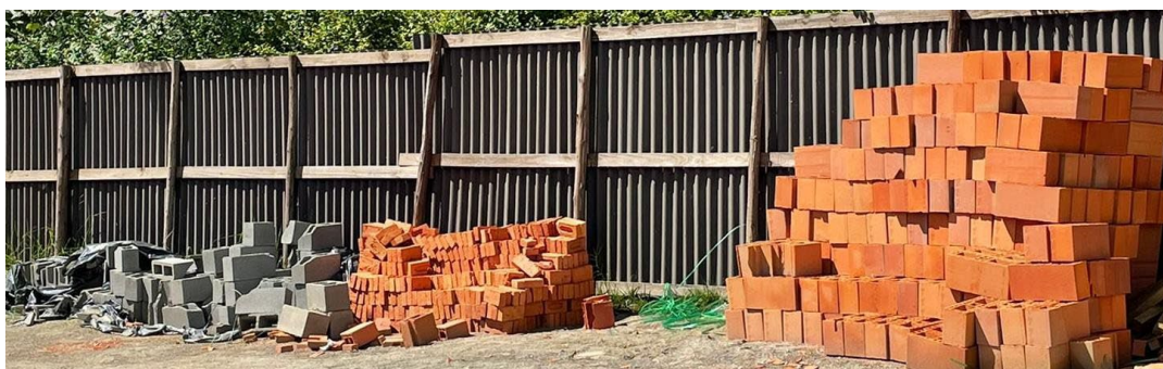
Figura 28 - Armazenamento de blocos cerâmicos e de concreto
