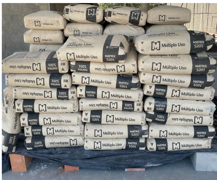
Figura 12 - Armazenamento de argamassa em sacos
