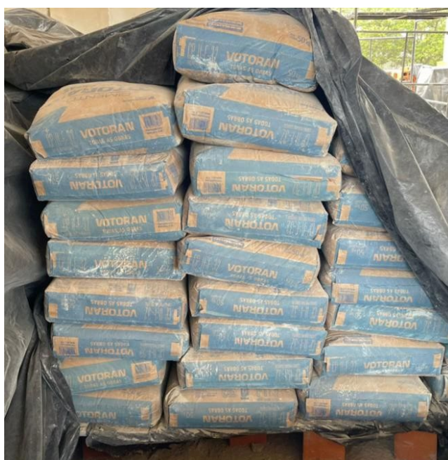
Figura 11 - Armazenamento de cimento
