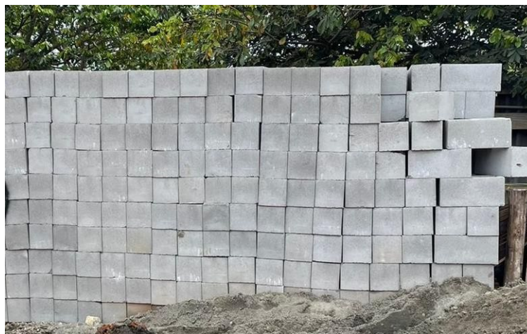
Figura 14 - Armazenamento de blocos de concreto
