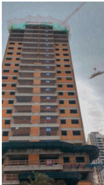
Fotografia 3 - Transporte das pré-vigas por grua
