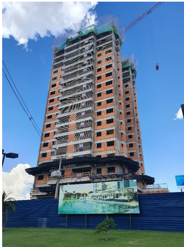
Fotografia 4 - Transporte utilizando grua
