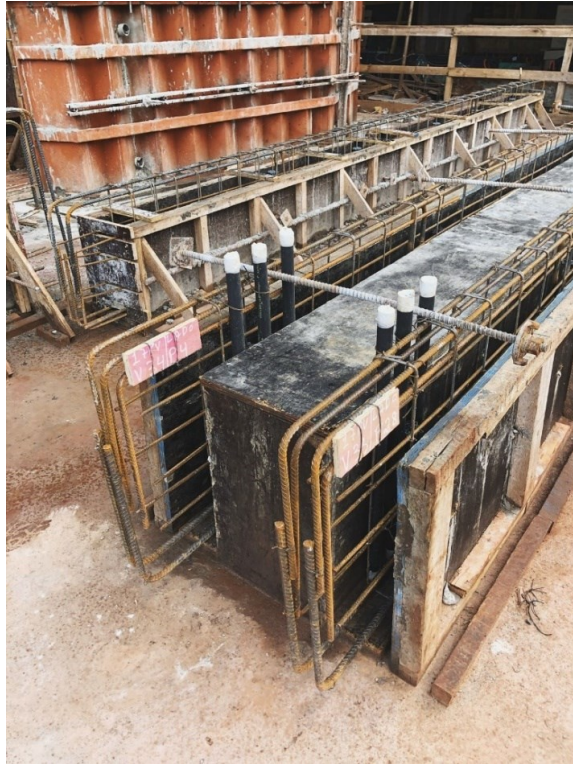
Fotografia 2 - Berço das pré-vigas
