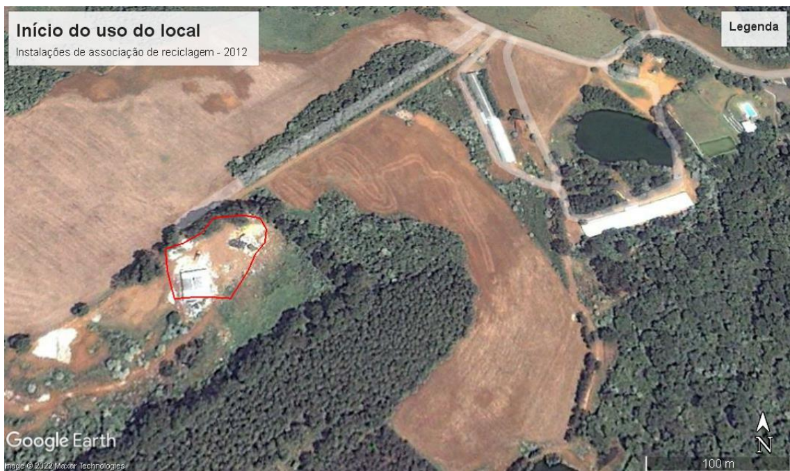
Figura 3: Local após instalação de barracão de reciclagem.
