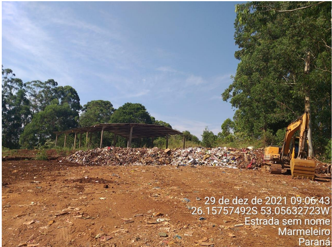
Figura 7: Local durante a remoção de resíduos
