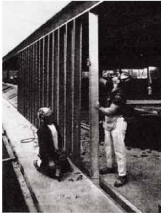
Figura 7: Montagem em light steel framing pelo método stick
