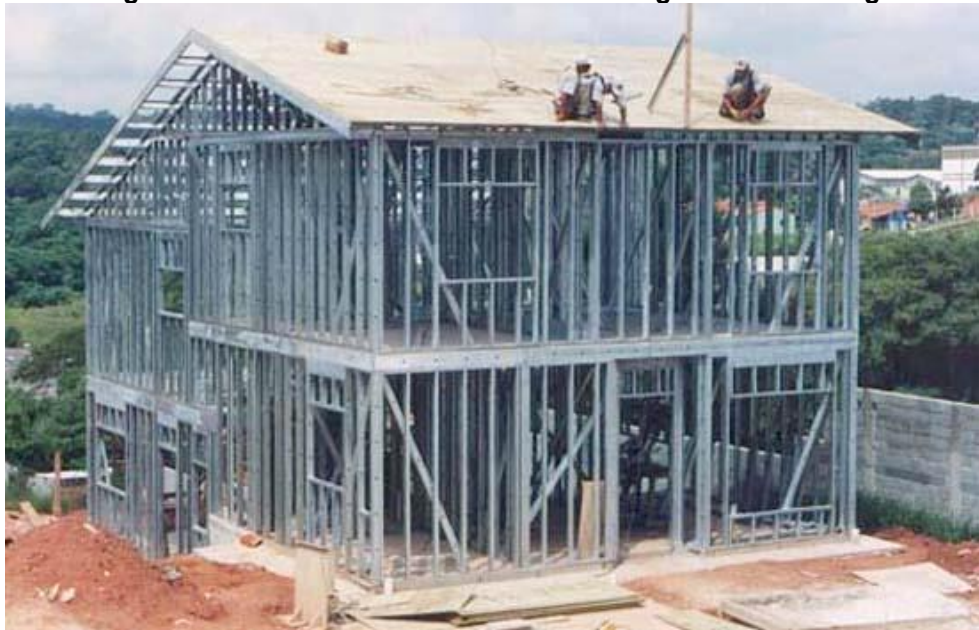
Figura 1: Estrutura de uma residência em Light Steel Framing.
