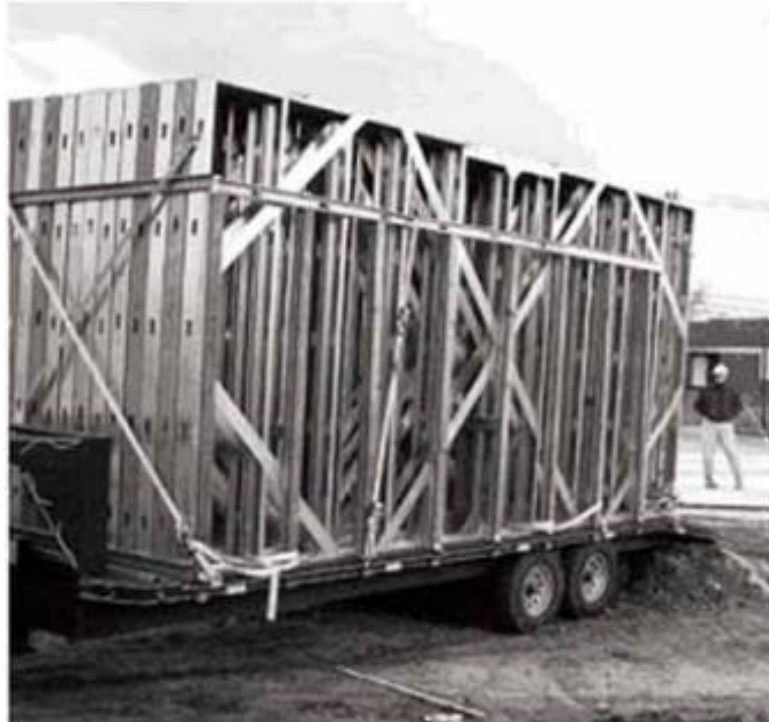
Figura 9: Painéis pré-fabricados sendo transportados
