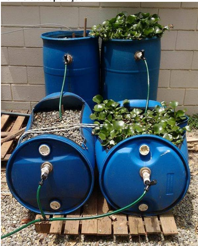
Figura 9 - Sistemas de wetlands construídas com tanque de armazenamento de esgoto, no início da operação.
