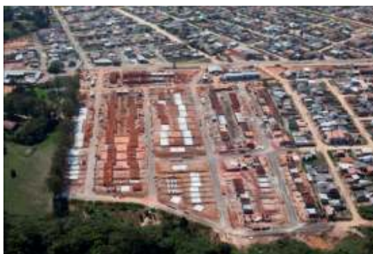
Figura 36 – Vista aérea da obra
