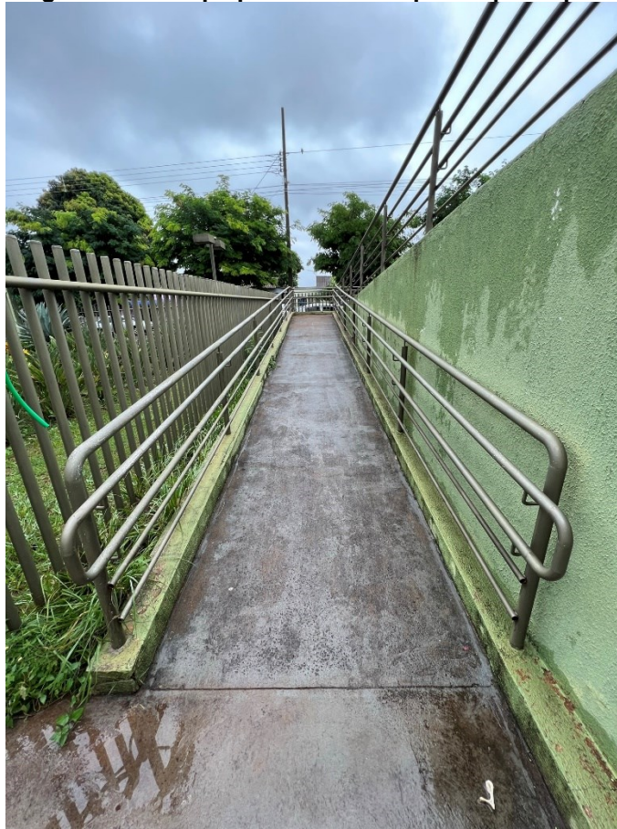
Fotografia 2 - Rampa para acesso a quadra poliesportiva
