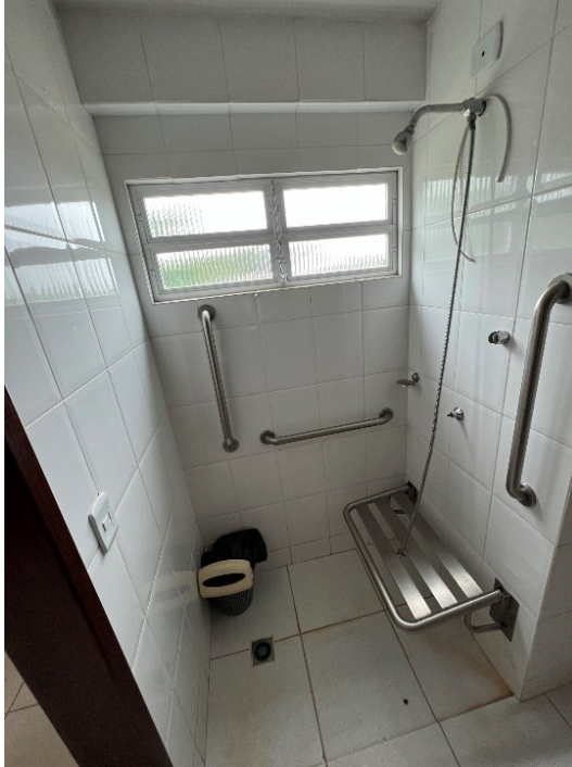
Fotografia 4 - Box de chuveiro adaptado
