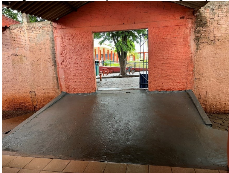
Fotografia 9 - Primeira rampa de acesso ao segundo prédio
