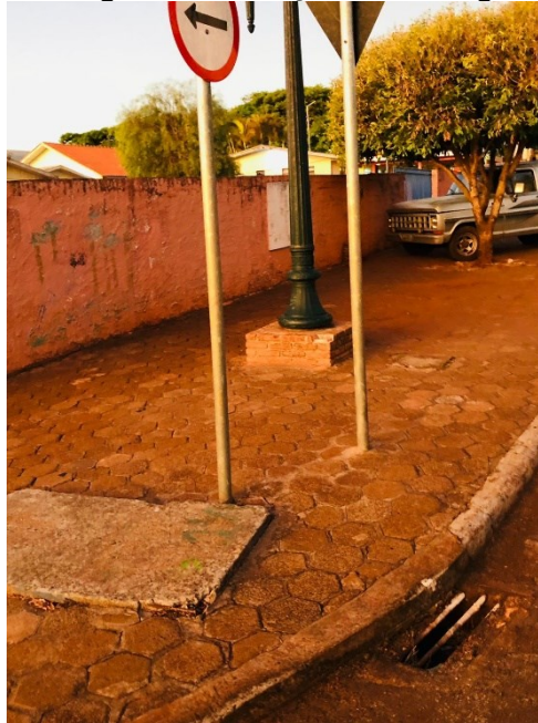
Fotografia 15 - Calçada do Colégio
