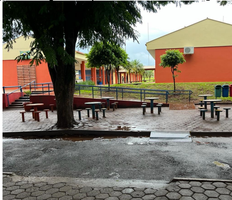
Fotografia 10 - Segunda rampa e escada de acesso ao segundo prédio
