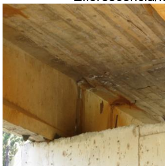
Eflorescência/Manchas de umidade
