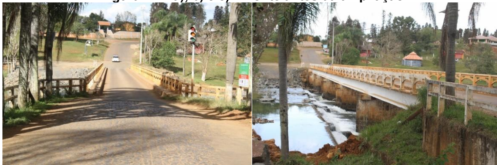
Figura 21 – a), b) e c) – Ponte antes da ampliação
