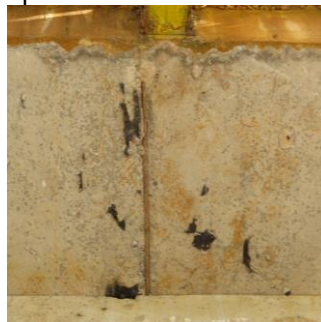
Armadura exposta
