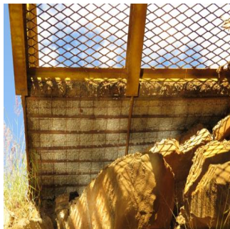
Armadura exposta
