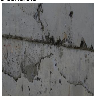
Fissura com 0,2 mm
