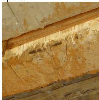
Armadura exposta
