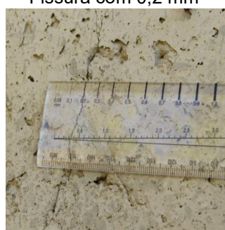
Fissura com 0,2 mm
