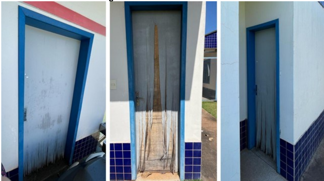
Figura 58 – Portas deterioradas
