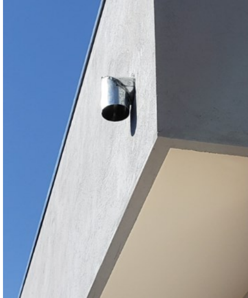
Figura 18 – Moldura de EPS revestida e fixada na extremidade do beiral
