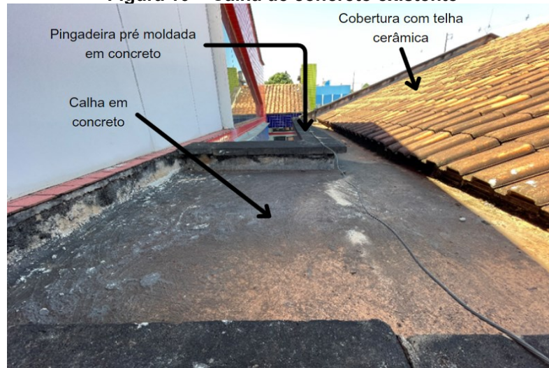
Figura 10 – Calha de concreto existente
