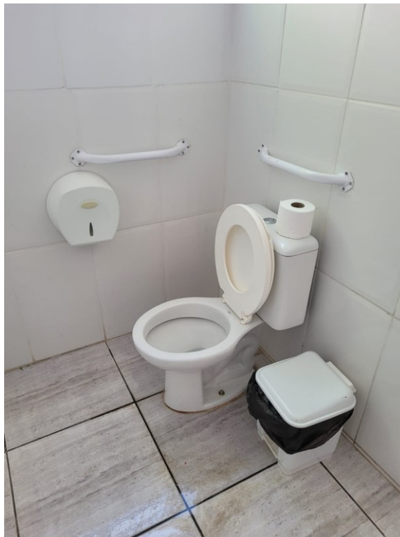
Fotografia 8 - Instalação sanitária com barras de apoio na USF João Nascimento Telles
