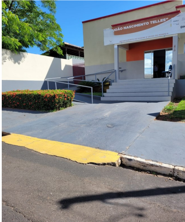
Fotografia 1 - Vaga para PCD sem sinalização na USF João Nascimento Telles
