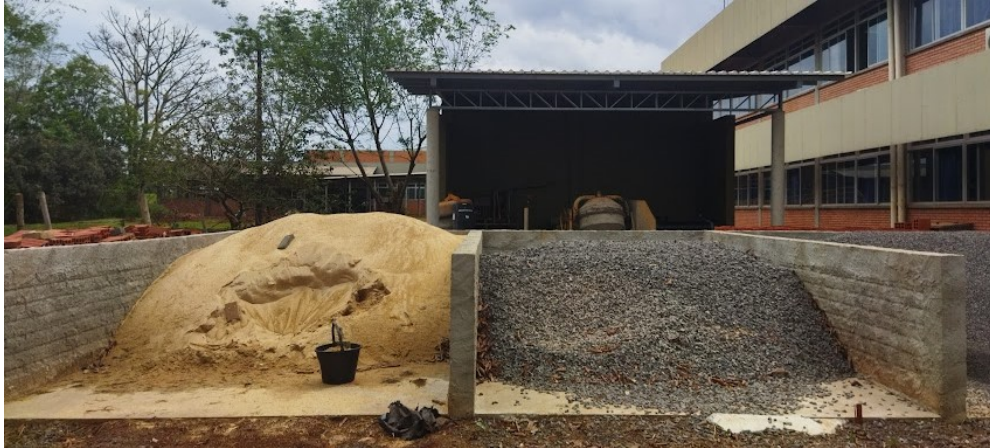
Fotografia 11 – Baía de agregados da universidade
