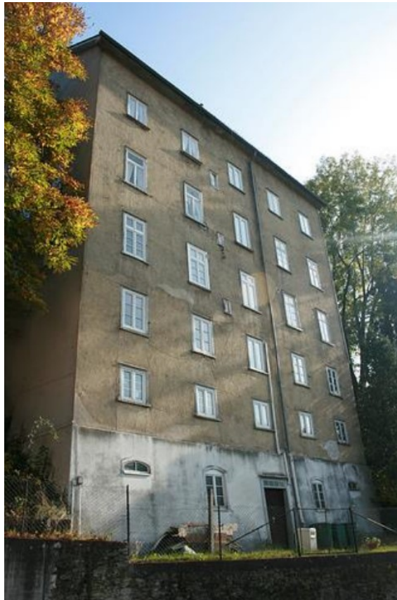
Fotografia 4 – Edifício feito em taipa de pilão
