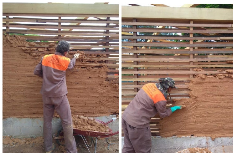
Fotografia 9 – Parede de terra sobre engradado de madeira
