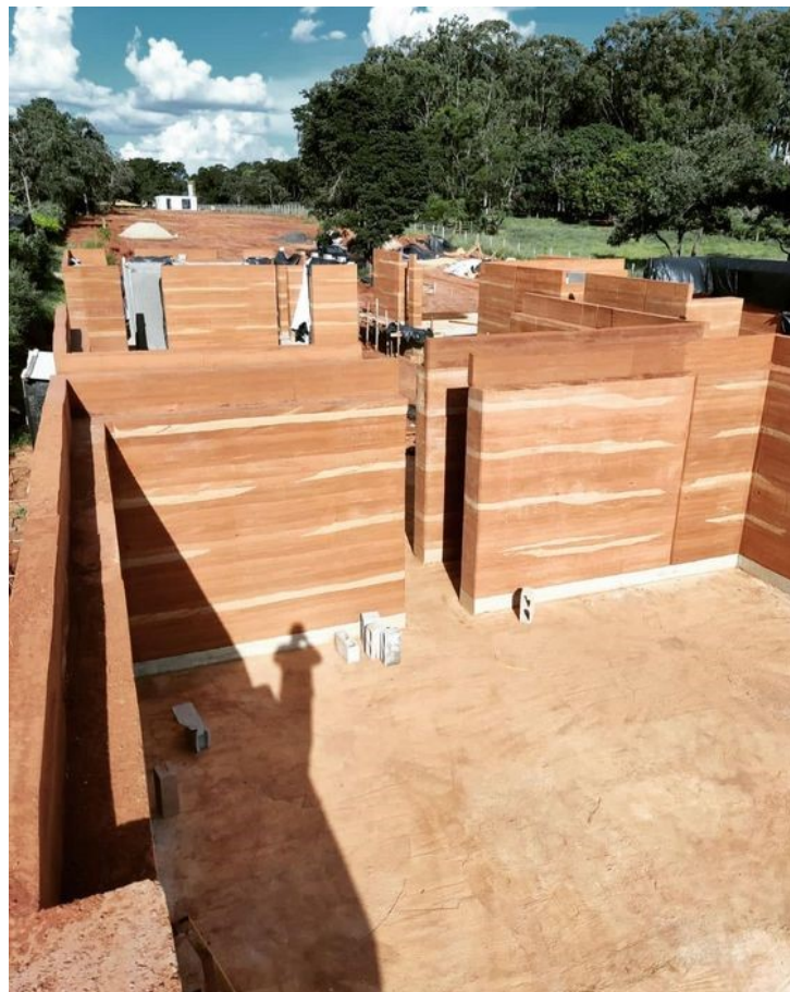
Fotografia 10 – Construção em taipa de pilão
