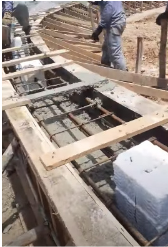
Figura 39 Concretagem do anel
