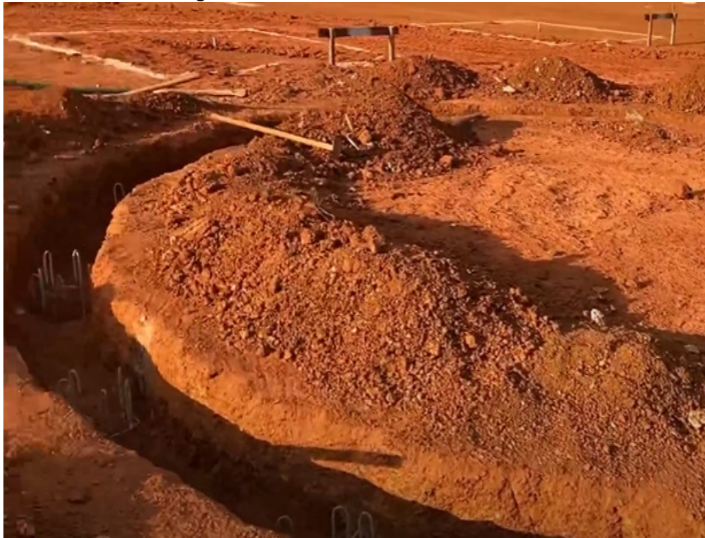
Figura 33 Anel de coroamento escavado
