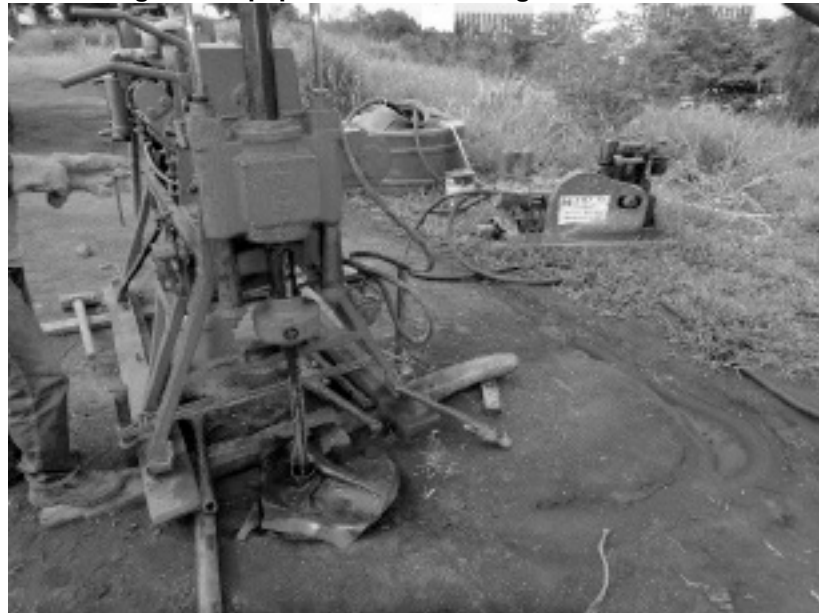
Figura 4 Equipamento de sondagem rotativa
