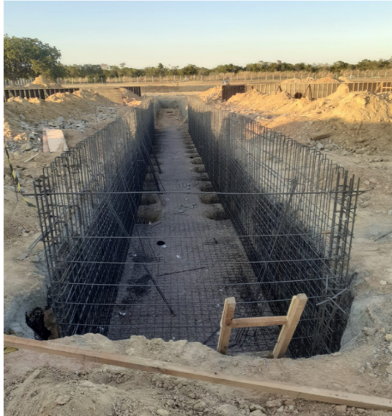
Figura 40 Armadura do túnel de escoamento
