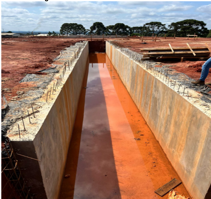
Figura 41 Paredes do tunel de escoamento
