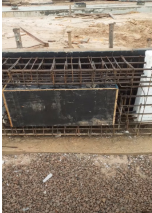
Figura 37 Forma de abertura do tunel de escoamento
