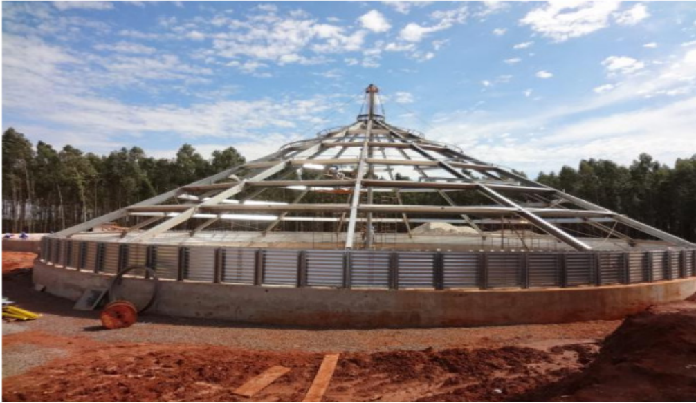
Figura 12 Estrutura do telhado
