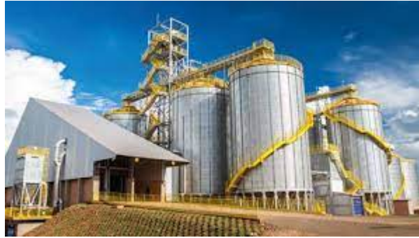
Figura 15 Escadas de manutenção
