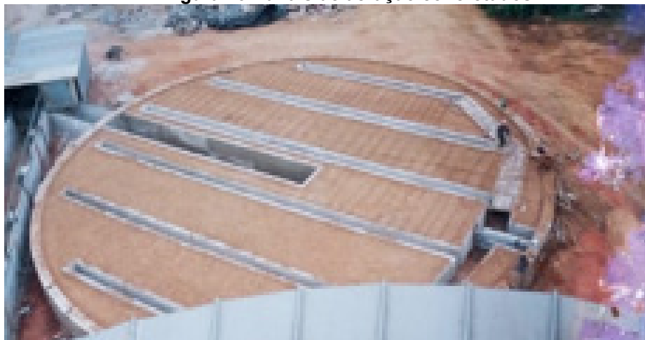
Figura 43 Canais de aeração concretados
