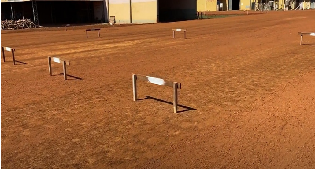
Figura 30 Demarcação da obra
