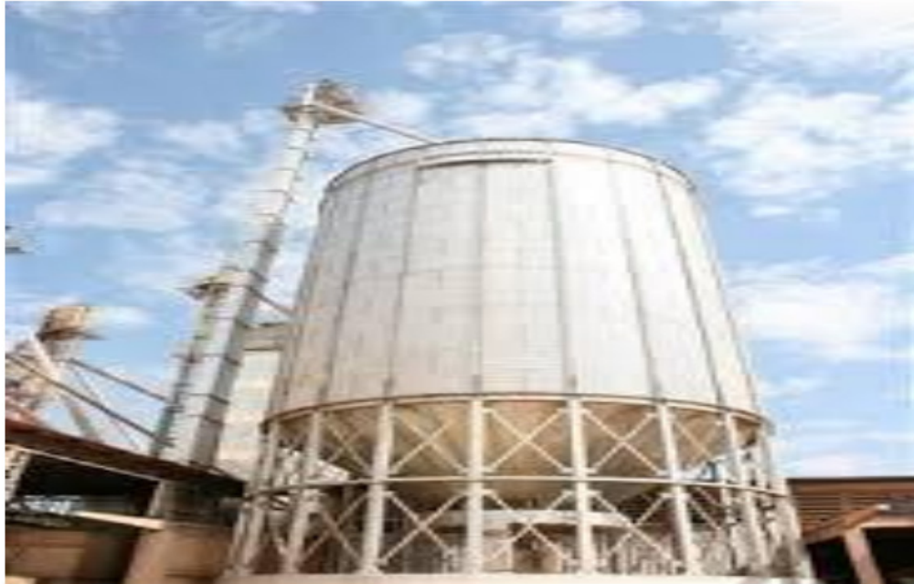
Figura 8 Silos metálicos elevados
