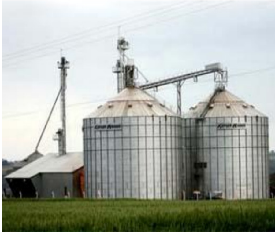
Figura 7 Silos metálicos de fundo plano
