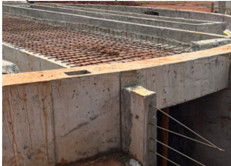
Figura 42 Armadura da laje do tunel de escoamento
