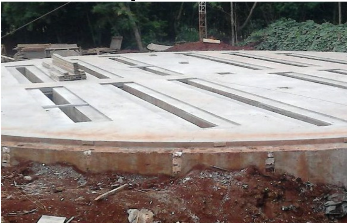
Figura 44 Piso concretado
