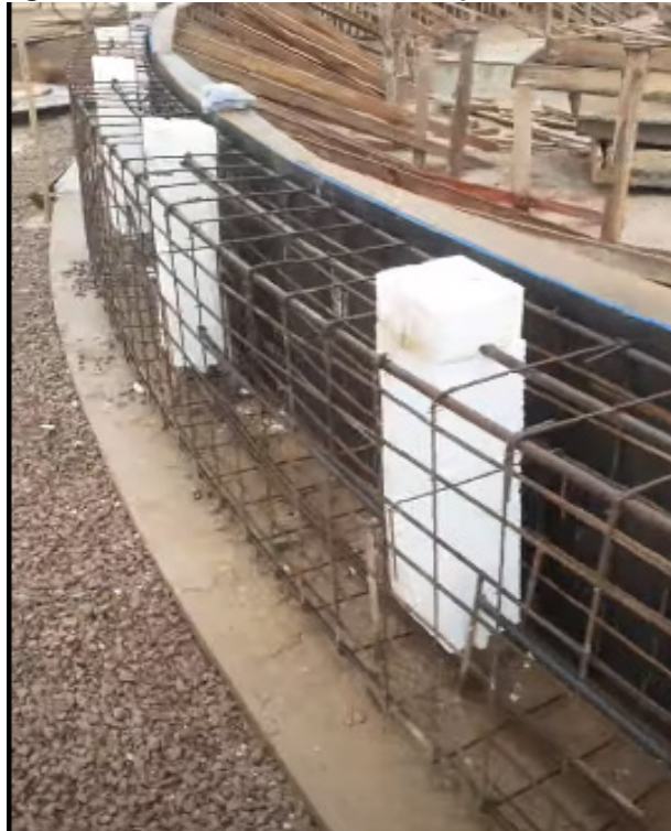
Figura 36 Armadura do anel e espera do montante
