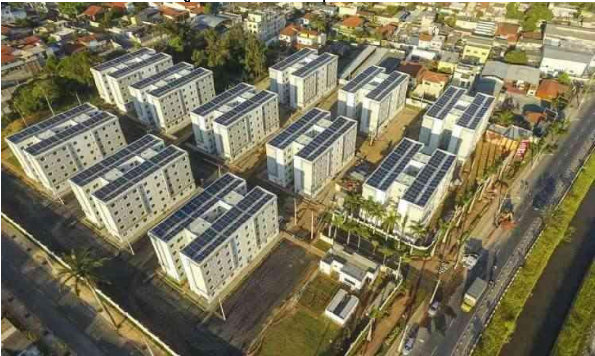
Figura 9 - Condomínio Spazio Parthenon
