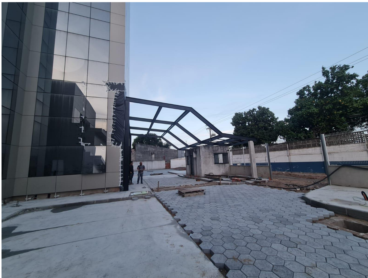
Figura 4: Pavimentação externa sendo realizada.
