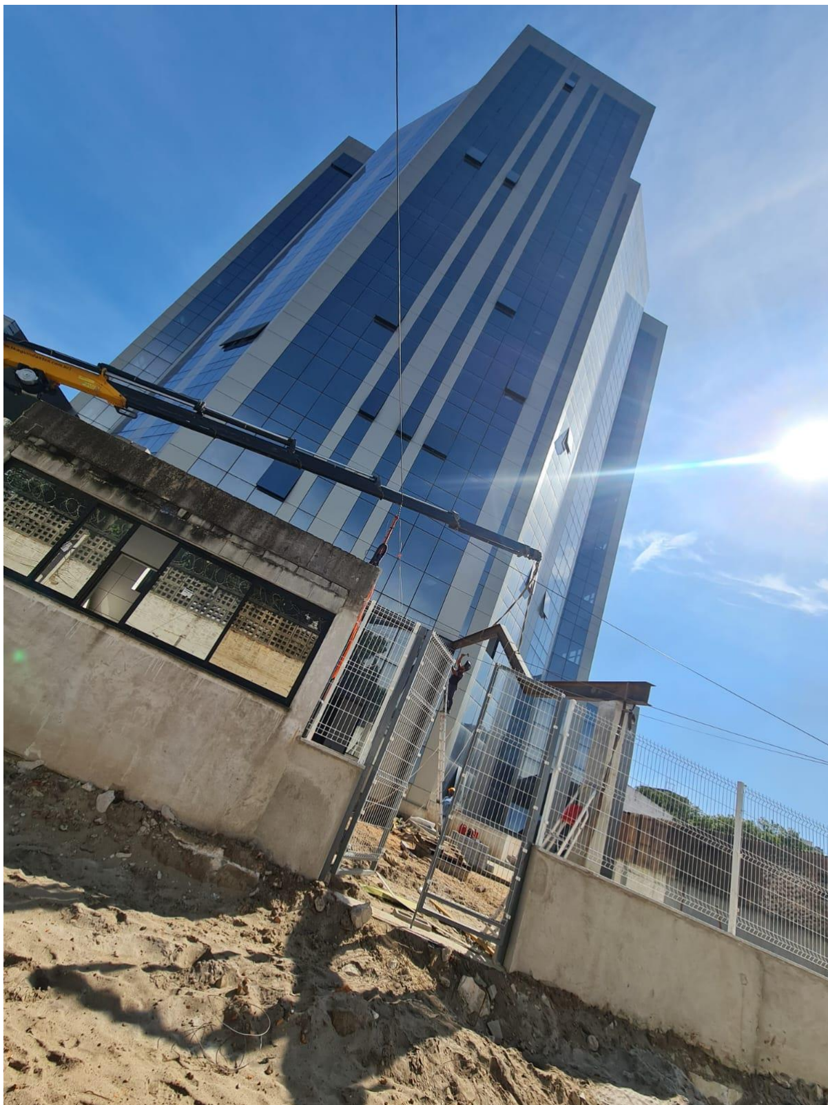
Figura 3: Vista externa da edificação.
