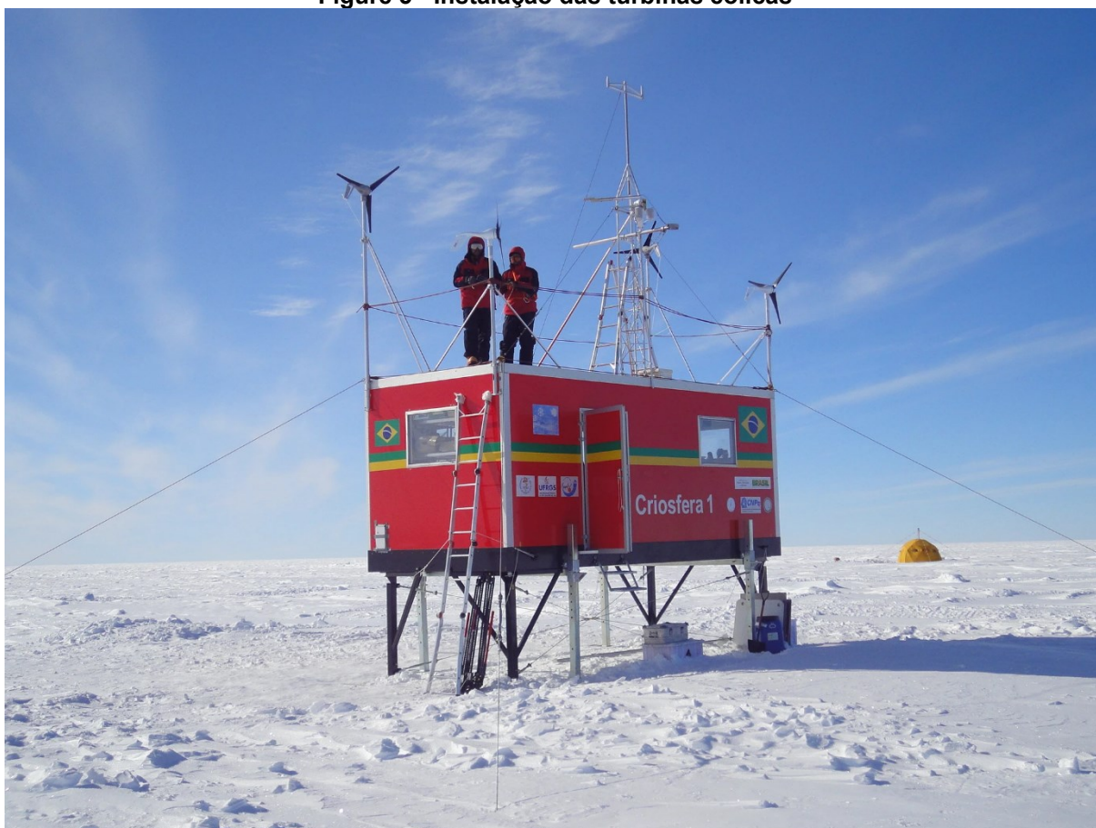
Figure 5 - Instalação das turbinas eólicas
