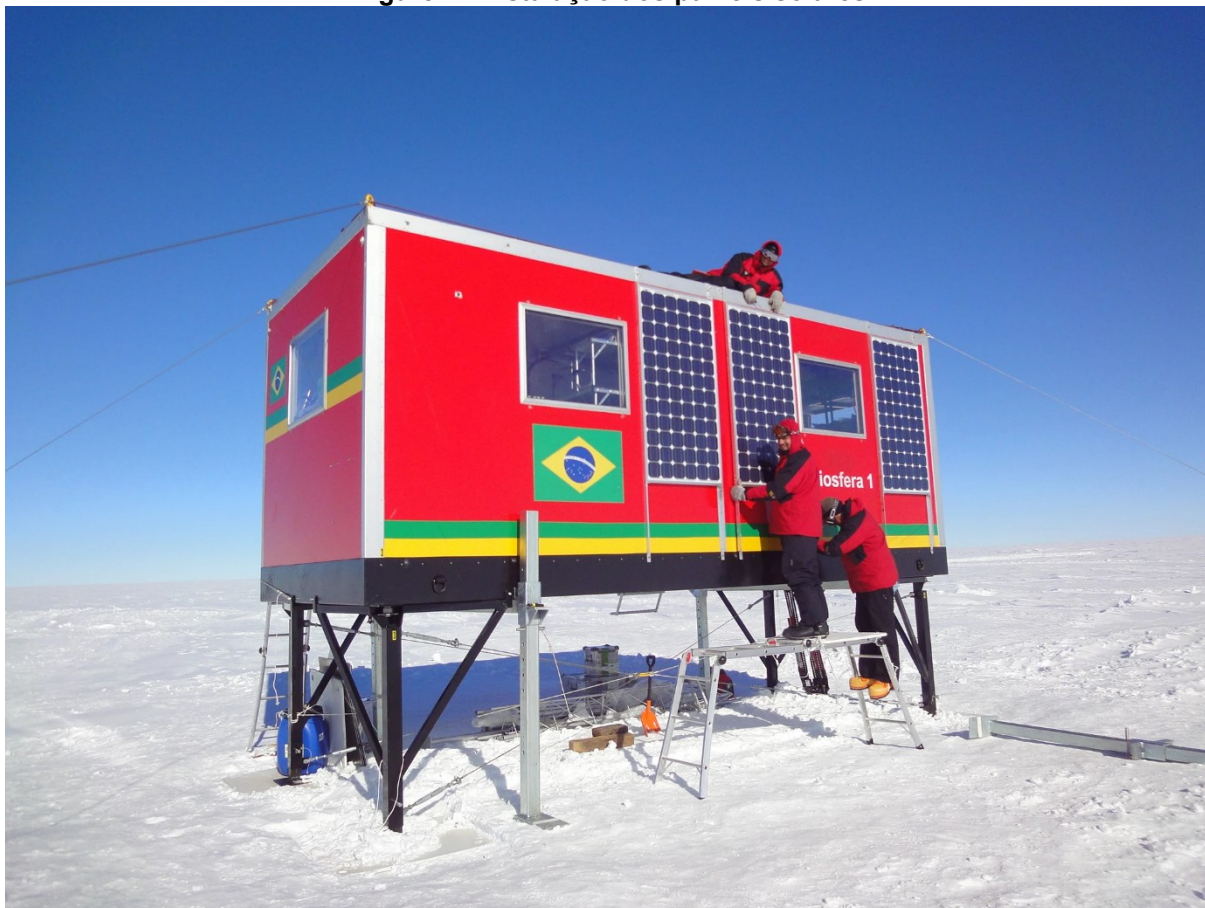
Figure 4 - Instalação dos painéis solares
