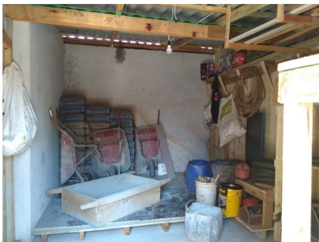
Figura 8 - Armazenagem de cimento e cal da obra 1
