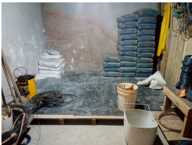
Figura 18 - Armazenagem de cimento e cal na obra 2
