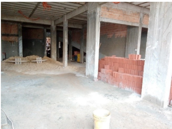
Figura 23 - Armazenagem de materiais na obra 3
