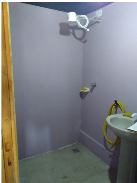
Figura 1 - Instalações Sanitárias da obra 1
