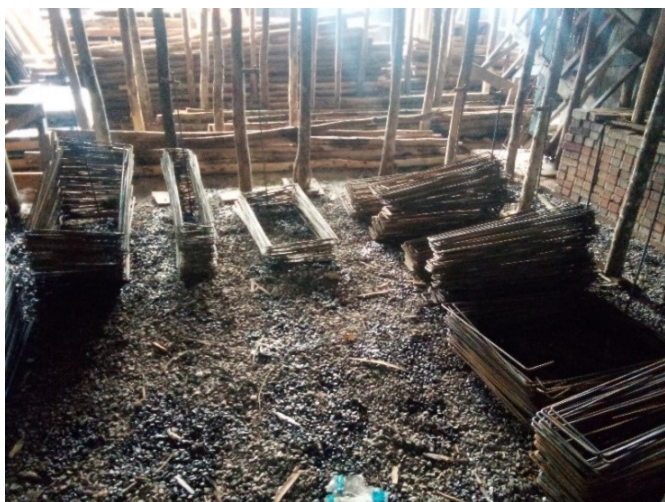
Figura 16 - Armazenagem de ferragem da obra 2
