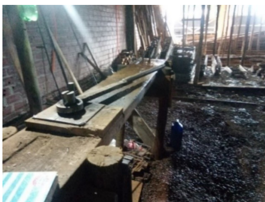
Figura 13 - Bancada de armação de aço da obra 2
