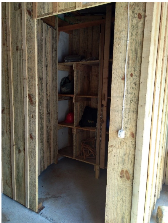
Figura 2 - Vestiário da obra 1
