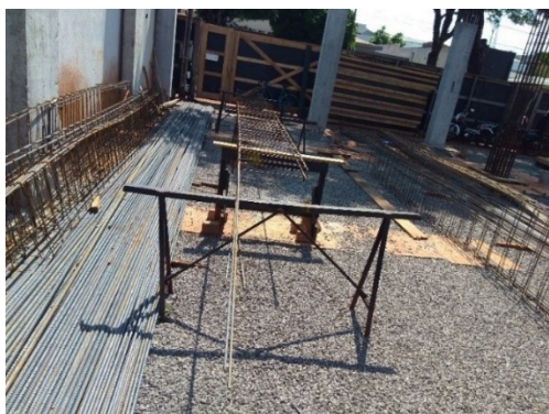
Figura 4 - Bancada da armação de aço da obra 1
