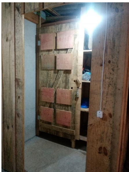
Figura 11 - Vestiário da obra 2
