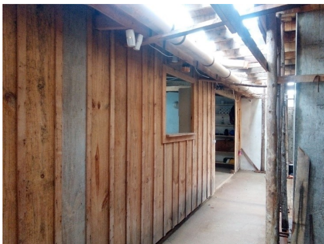
Figura 19 - Área externa do canteiro da obra 2
