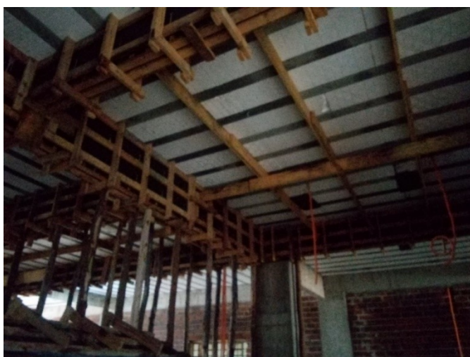
Figura 15 - Mesa de carpintaria da obra 2
