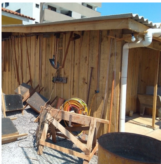
Figura 9 - Área externa de canteiro da obra 1
