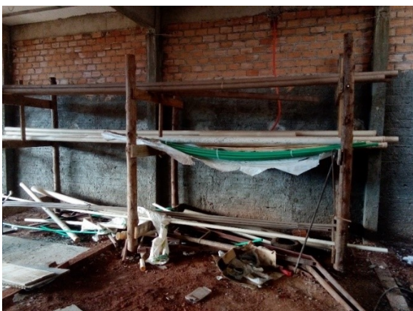
Figura 25 - Armazenagem de tubos na obra 3
