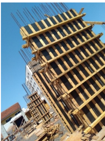
Figura 6 - Estruturas de concreto da obra 1
