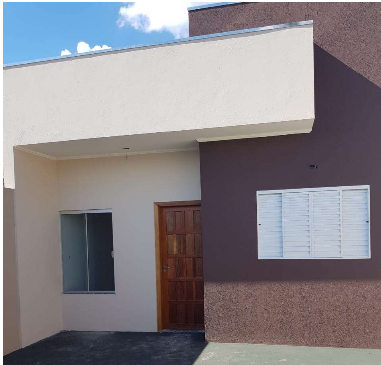
Figura 10 – Edificação 1 após conclusão da pintura.
