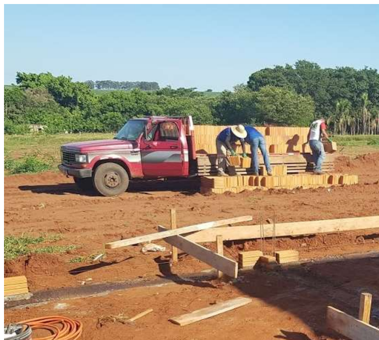
Figura 18 – Blocos 6 furos sendo descarregados.
