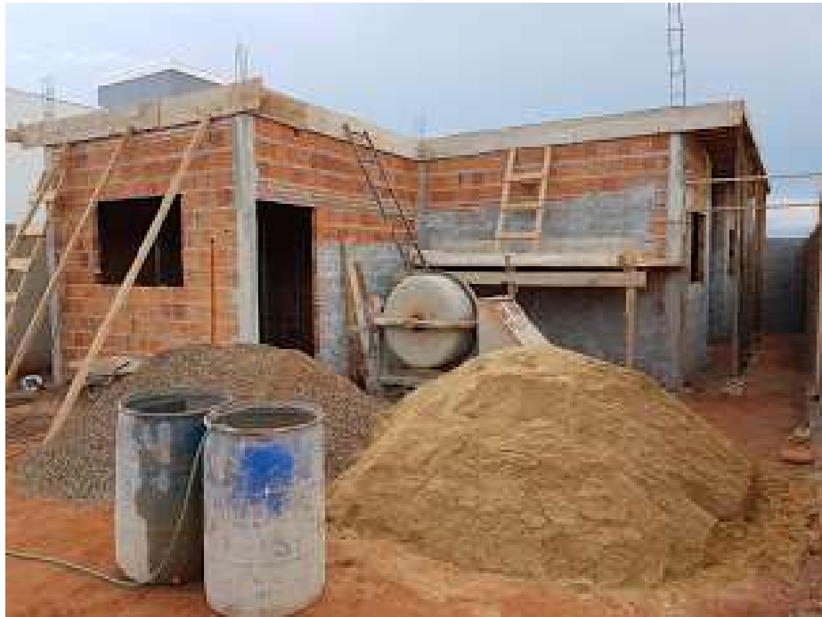
Figura 12 – Layout pronto no dia anterior a concretagem.
