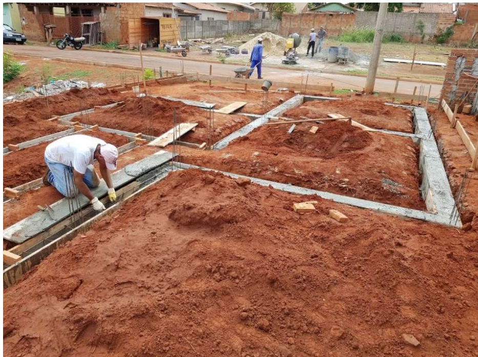
Figura 13 – Distância entre a Edificação 1 e a betoneira.
