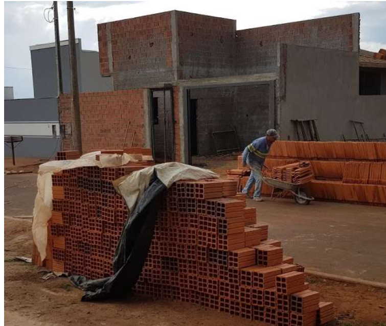
Figura 17 – Telhas sendo descarregadas.
