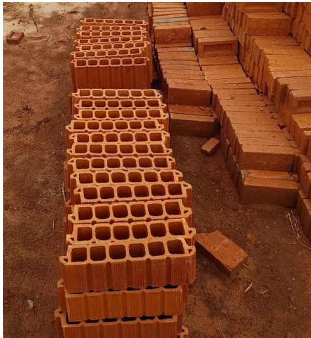
Figura 16 – Lajotas que sobraram após concretagem da laje.
