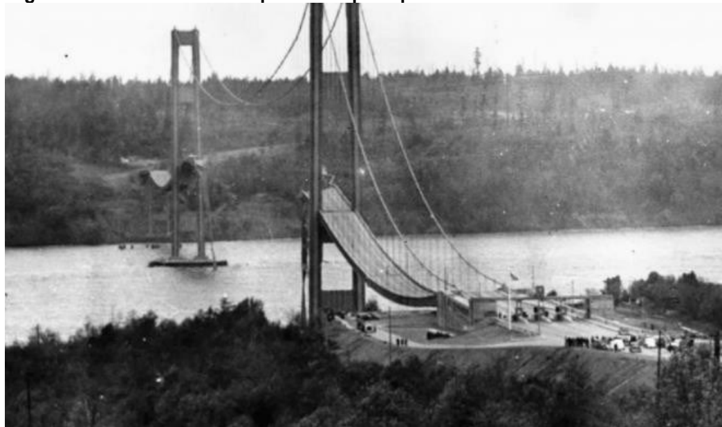
Figura 1 - Ponte de Tacoma que se rompeu após entrar em ressonância.
