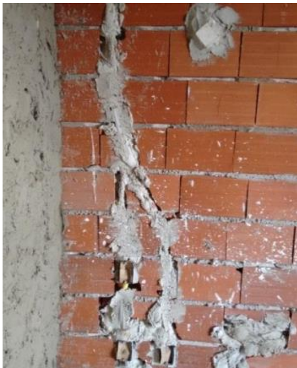
Figura 12 — Alvenaria cortada para passagem de dutos
