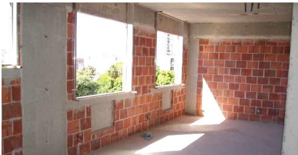
Figura 11 — Alvenaria de vedação ligada a estrutura de concreto armado
