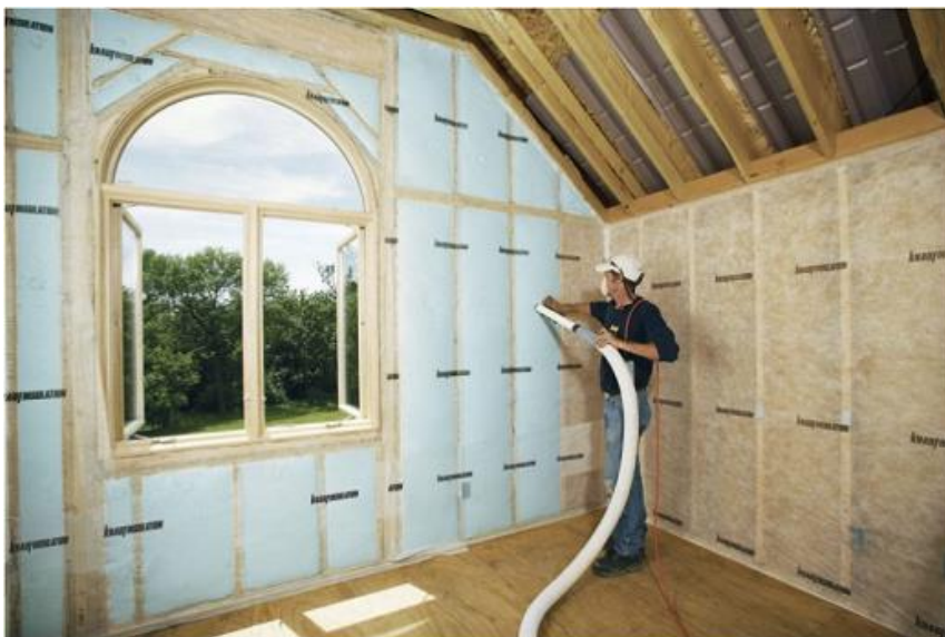
Figura 6 — Revestimento interno com lã de vidro
