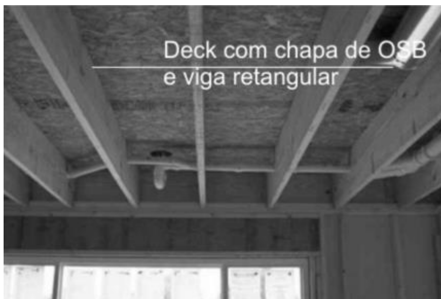
Figura 2 — Piso Pav. Superior (vista inferior)
