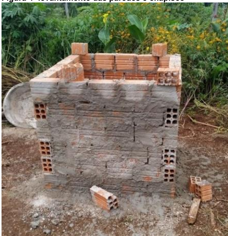
Figura 4- levantamento das paredes e chapisco
