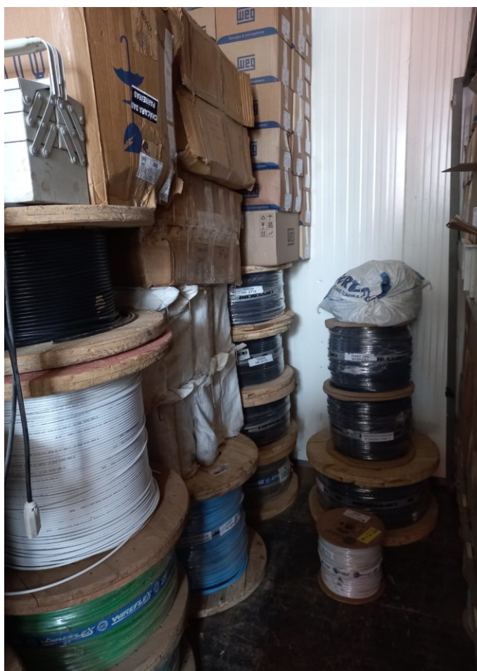
Figura 2 - Container de elétrica – interno
