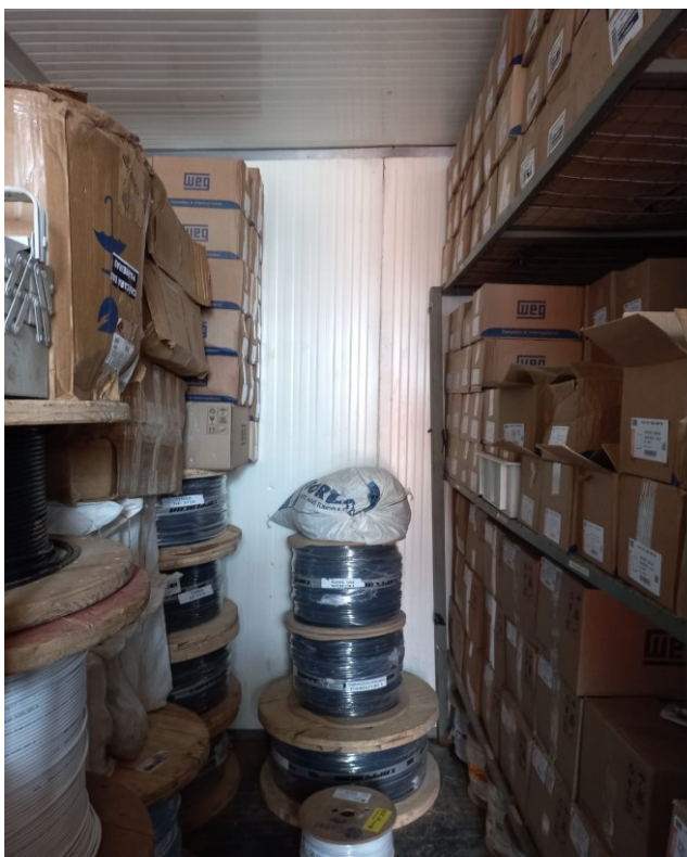
Figura 3 - Container de elétrica – interno
