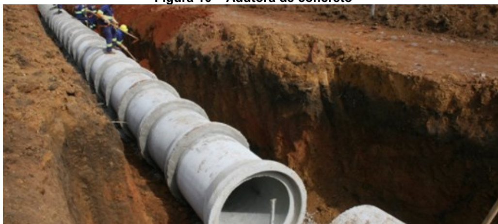
Figura 10 – Adutora de concreto
