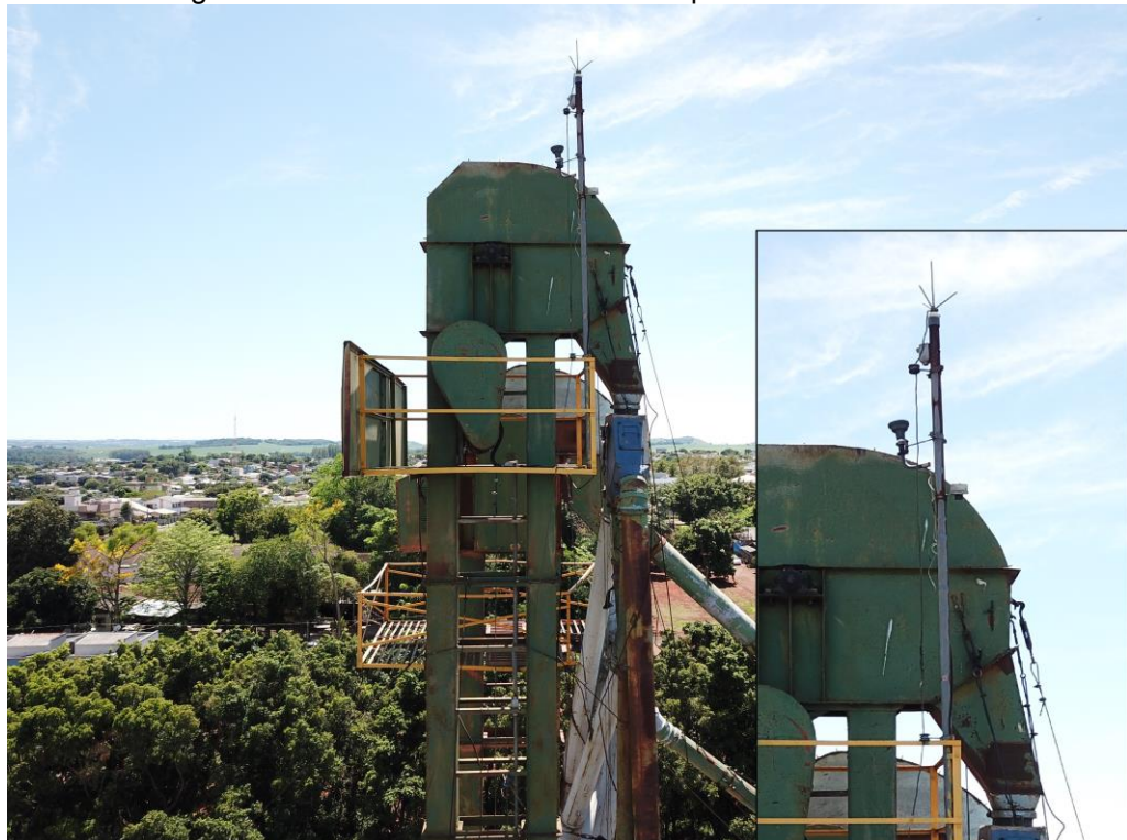
Imagem 5 - Torre do elevador com realce para Haste de Franklin.
