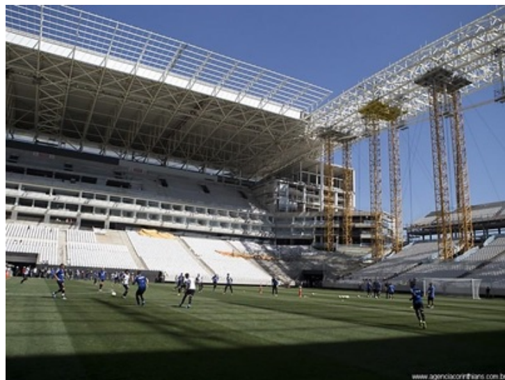
Figura 1.2 – Estrutura treliçada metálica utilizada na Arena Corinthians.
