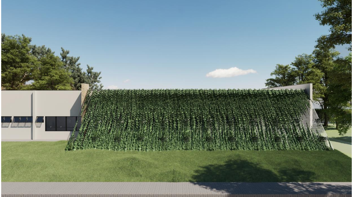
Figura 27 – Método Extensivo com Fachada Verde indireta – Parede Leste do Bloco J - Biblioteca
