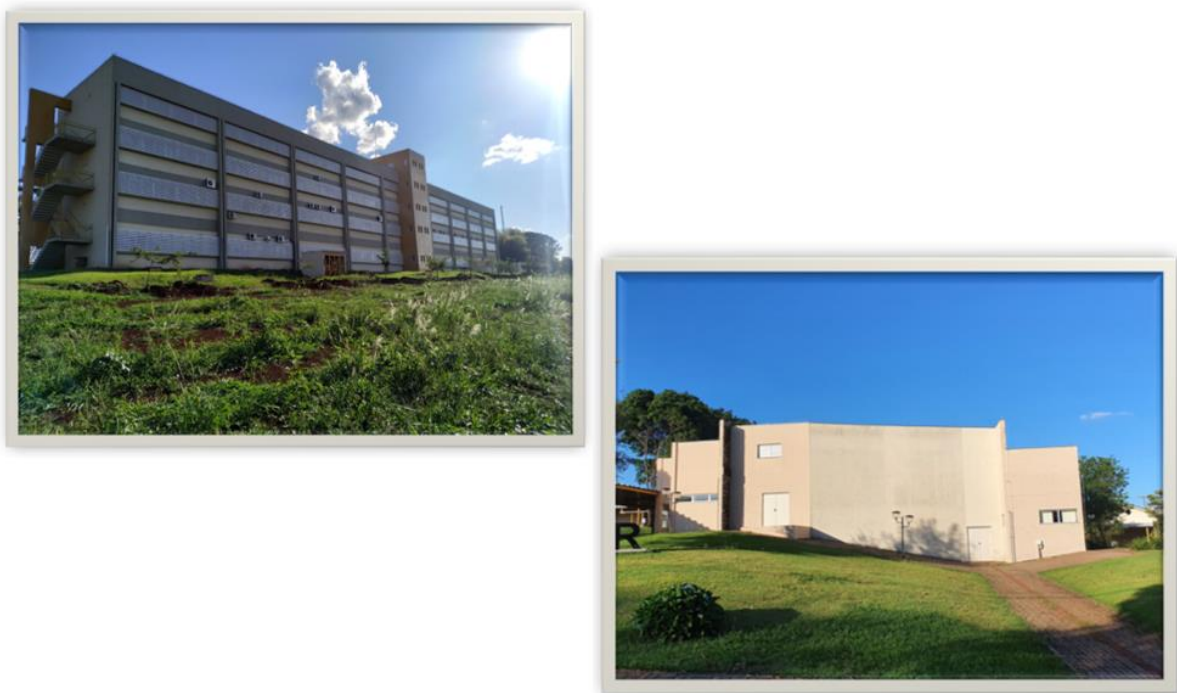
Figura 13 – Bloco G10 parede Leste e Anfiteatro Douglas Sampaio Henrique parede Oeste
