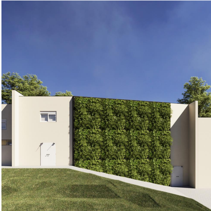
Figura 31 – Método Intensivo com Parede Viva Contínua – Anfiteatro Douglas Sampaio Henrique
