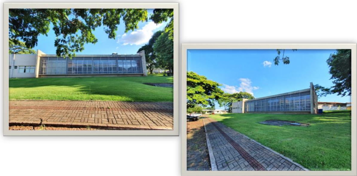
Figura 12 – Bloco J, Biblioteca – Parede Leste
