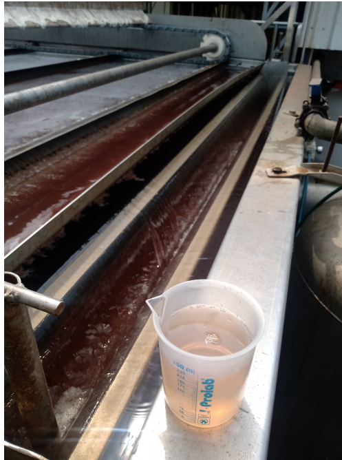
Figura 3 – Ponto de coleta do efluente tratado na saída dos flutuadores
