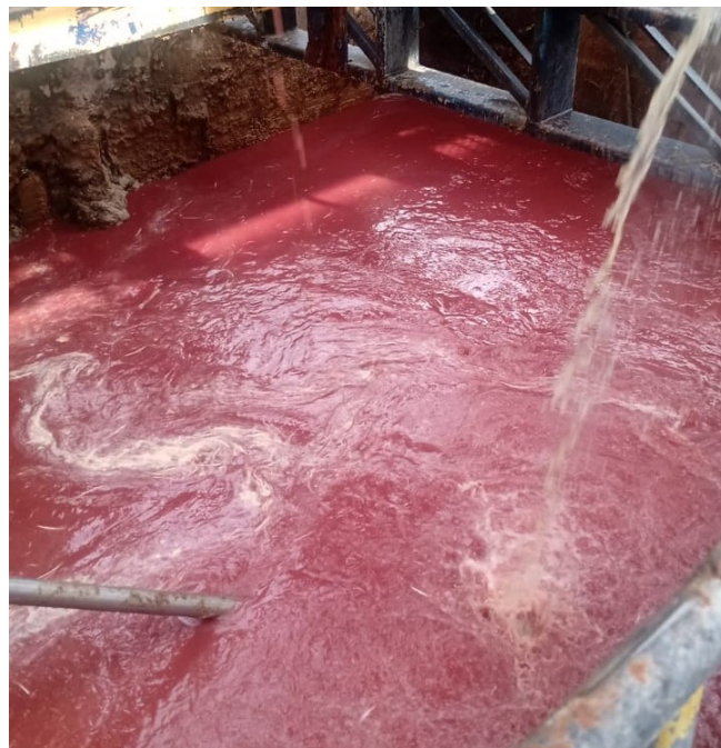
Figura 6 – Tanque de Equalização
