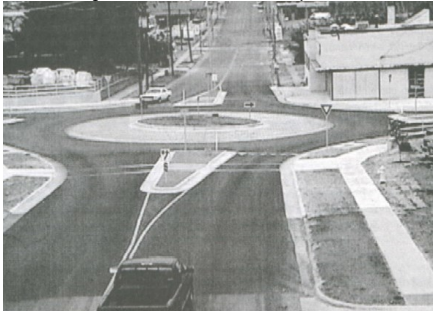
Figura 8 - Interseção em nível do tipo rótula
