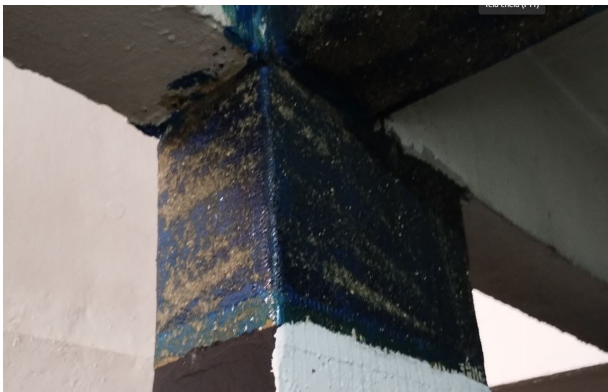
Figura 40 – Pilar PR2 segundo subsolo reforçado
