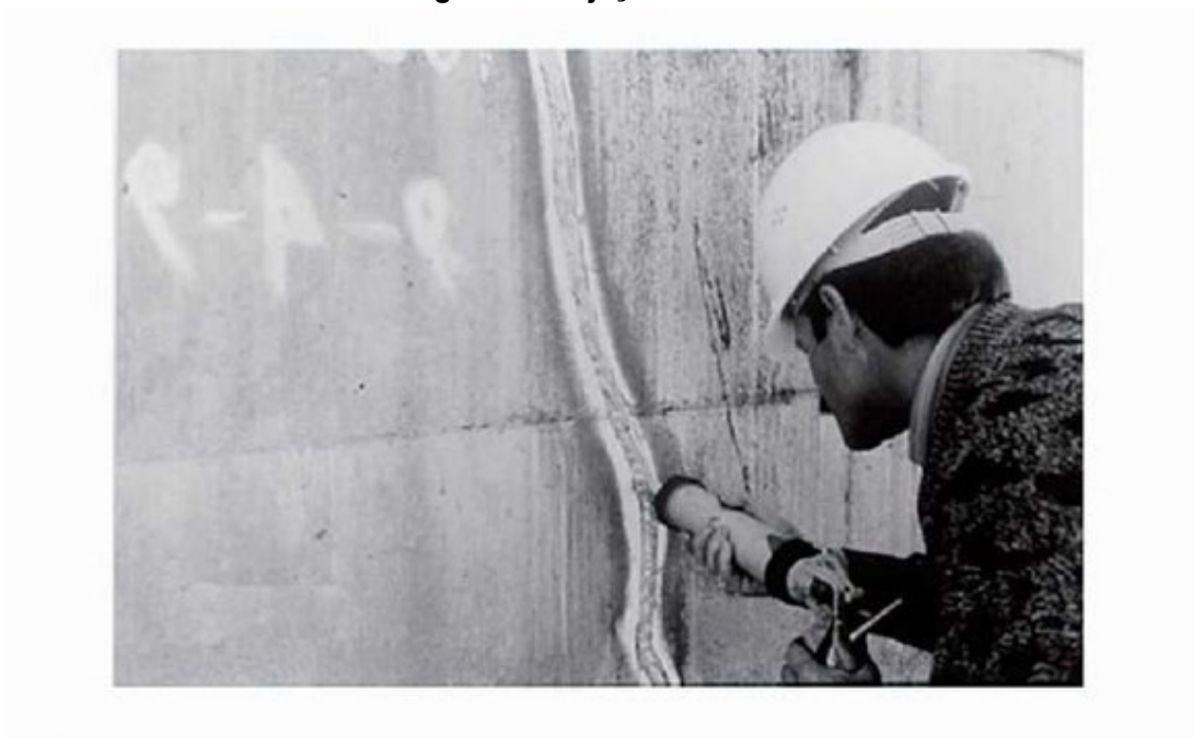
Figura 10 - Injeção de fissura
