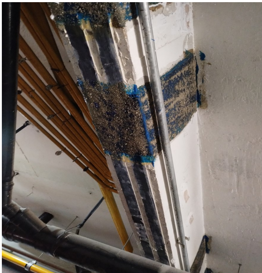
Figura 36 - Viga V29 reforçada
