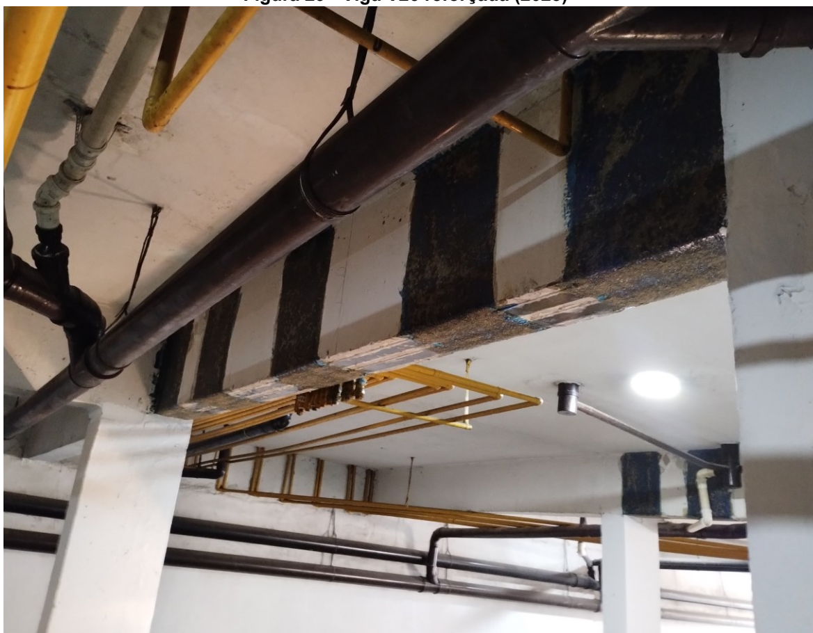
Figura 29 - Viga V26 reforçada (2023)
