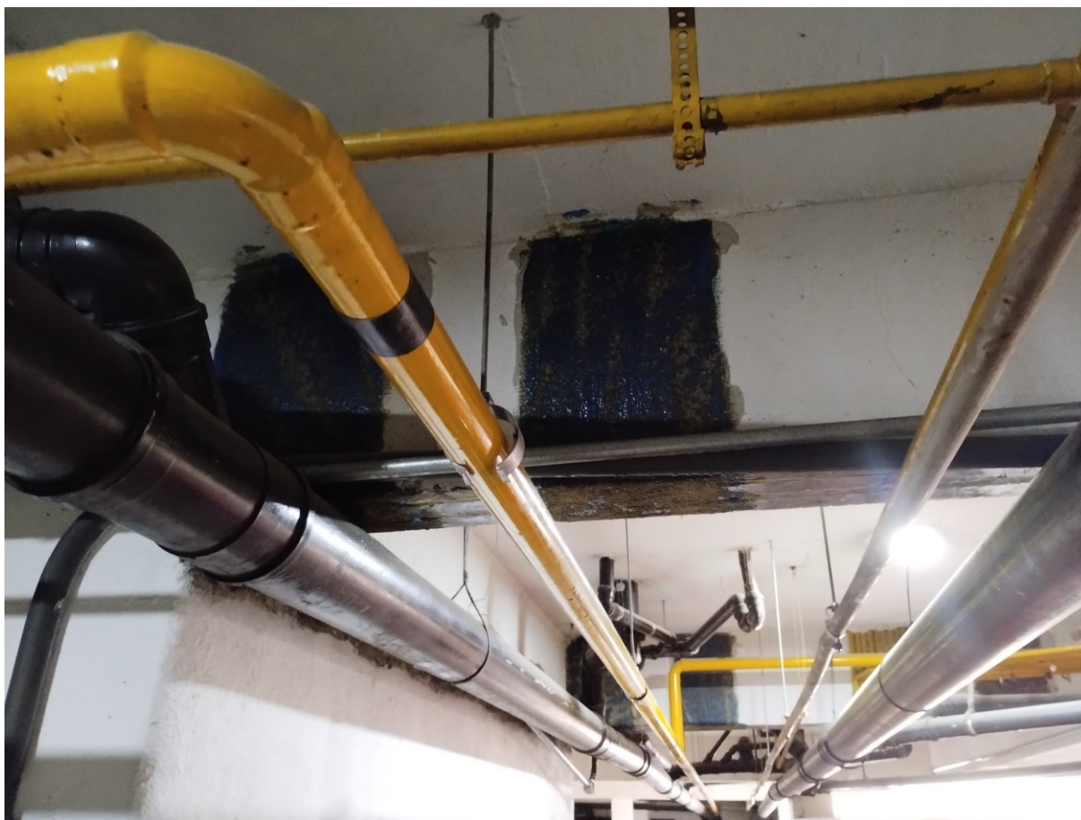
Figura 32 - Viga V29 reforçada (2023)
