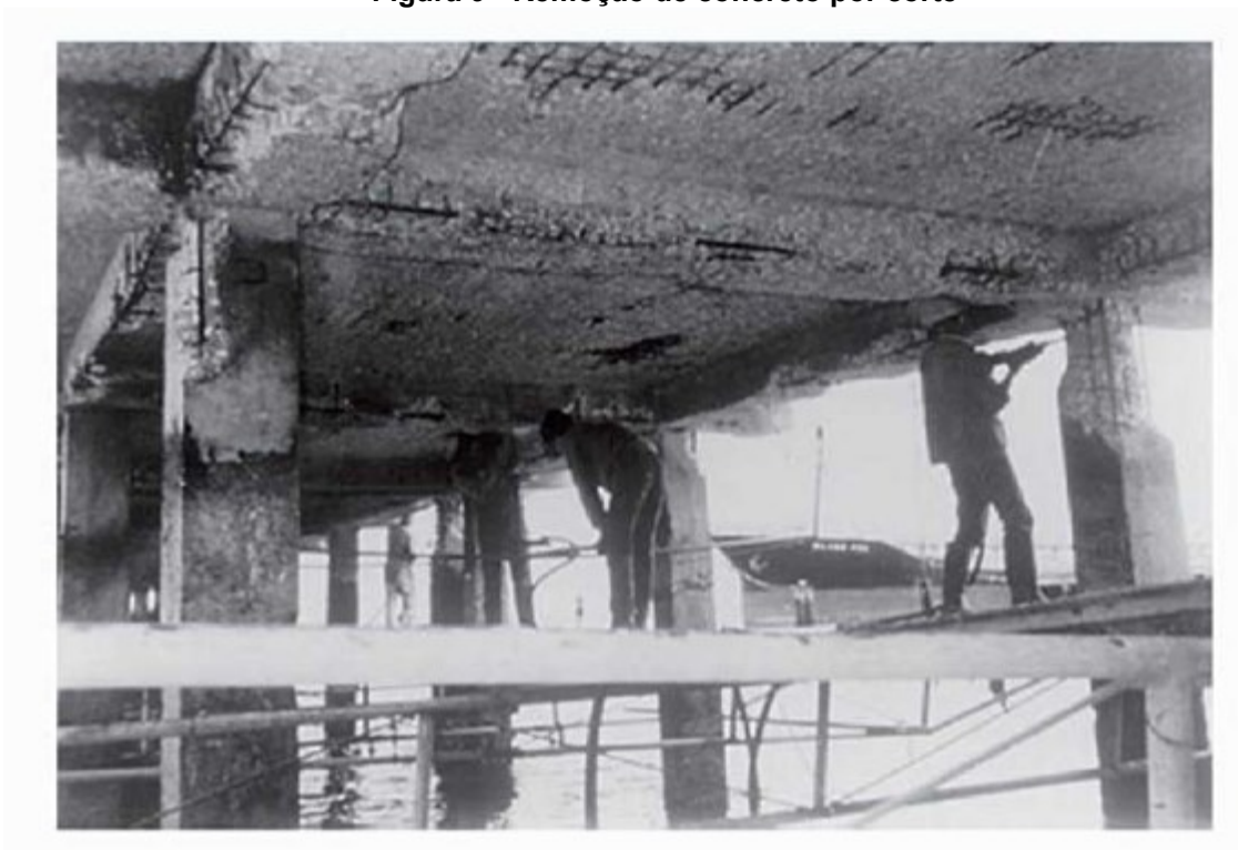
Figura 9 - Remoção de concreto por corte
