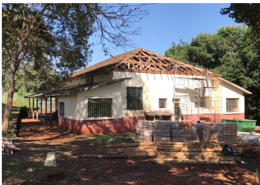
Fotografia 8 – Início do serviço no abatedouro
