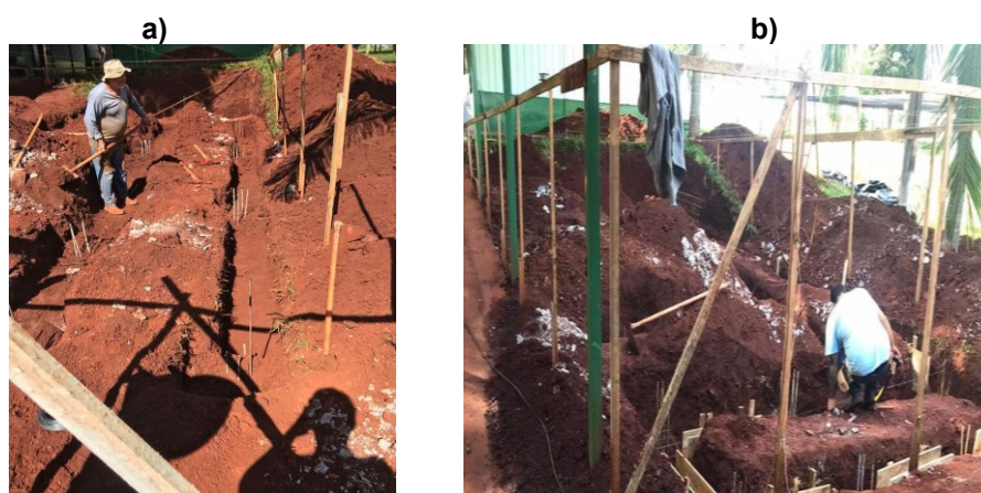
Fotografia 6 – Rampa 2 – Movimentação terra
