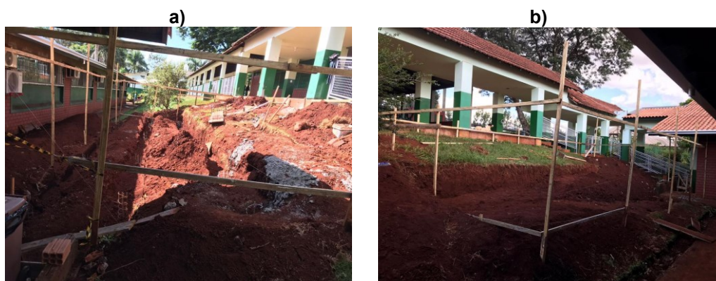
Fotografia 3 – Rampa 1 – Movimentação terra
