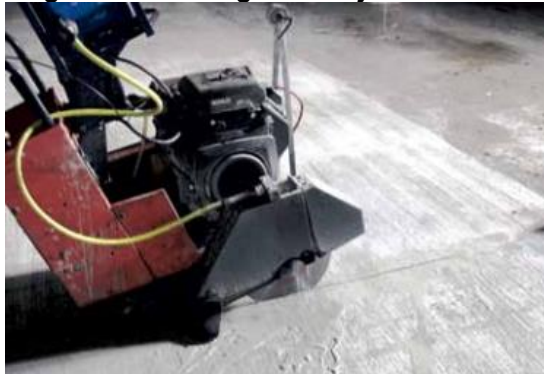
Figura 52 – Serragem da laje de concreto
