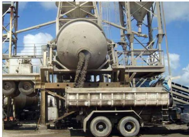
Figura 18 – Usina pavimentadora do trecho da Rodovia BR - 101, a maior rodovia de concreto em execução no mundo à época
