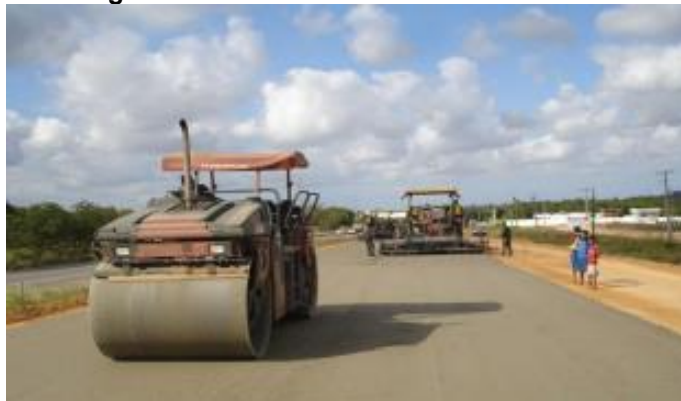
Figura 33 – Pavimento de concreto rolado
