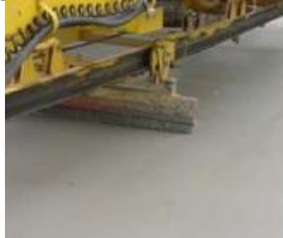
Figura 46 – Texturização mecanizada
