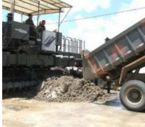
Figura 40 – Descarregamento do concreto
