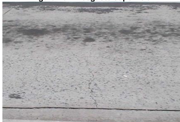
Figura 70 – Desgaste superficial
