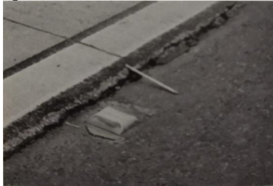
Figura 58 – Desnível rolamento-acostamento
