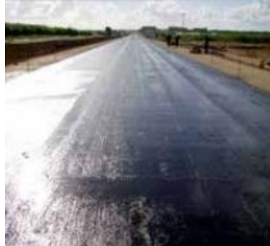
Figura 37 – Concreto compactado à rolo pintado com pintura betuminosa
