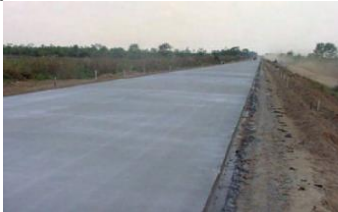
Figura 21 – Rodovia MT - 130, trecho em Primavera do Leste
