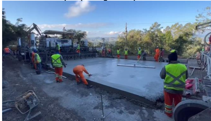
Figura 41 – Revestimento após passagem de pavimentadora na BR - 163 (SC)
