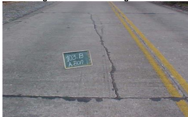
Figura 68 – Fissura longitudinal
