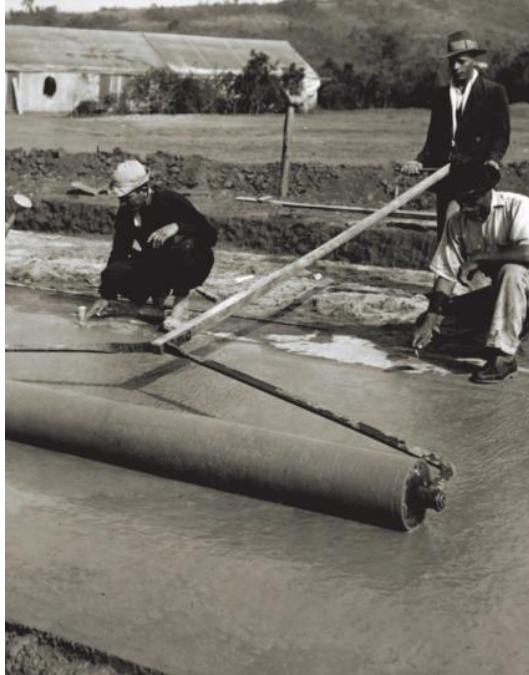
Figura 14 – Obra na estrada de São Miguel em 1940, trecho paulista da futura Rodovia Presidente Dutra
