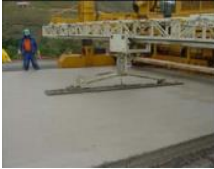
Figura 42 – Acabamento mecanizado
