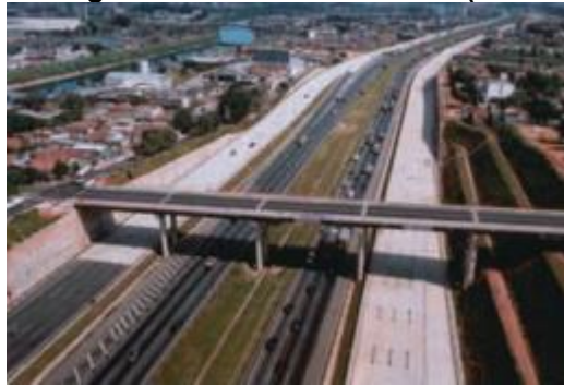
Figura 19 – Marginais da Rodovia SP - 208 (Castello Branco)
