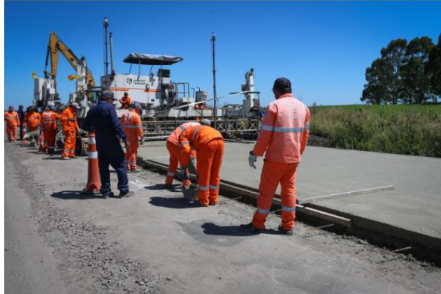
Figura 22 – Pavimentação rígida na PCR - 280 avança 1 km por dia
