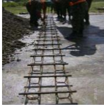
Figura 38 – Posicionamento das barras de transferências
