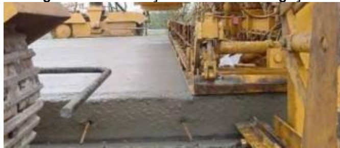
Figura 39 – Colocação das barras de ligação
