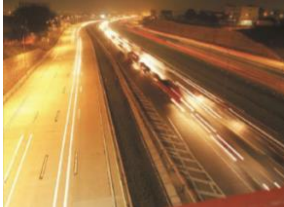
Figura 79 – Comparação da capacidade de reflexão da iluminação pública entre pavimento rígido e flexível (Rodovia Castello Branco em São Paulo)
