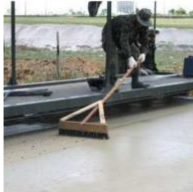
Figura 44 – Texturização manual com auxílio de passarela de serviço
