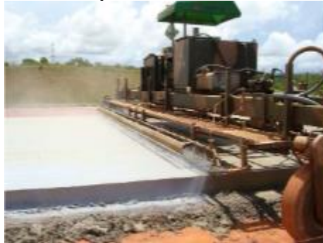
Figura 48 – Cura química realizada mecanicamente
