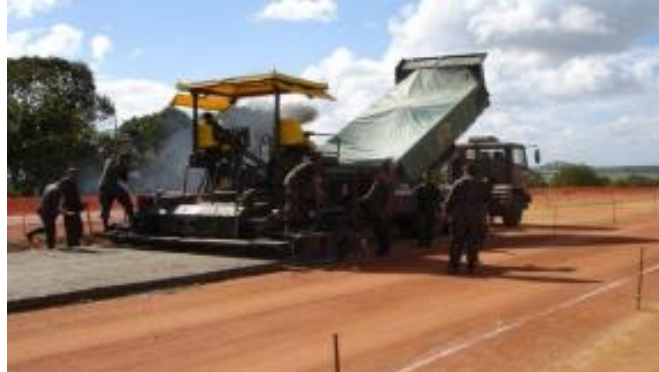
Figura 25 – Execução de sub-base de concreto compactado à rolo
