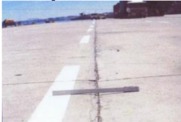
Figura 56- Bombeamento
