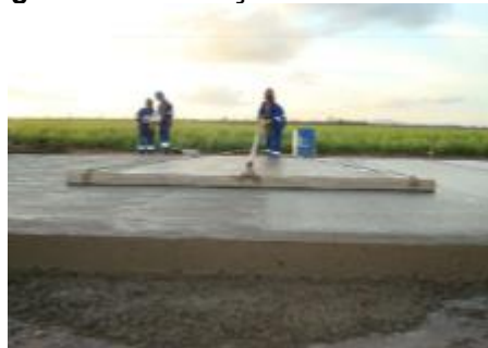
Figura 43 – Utilização do rodo de corte
