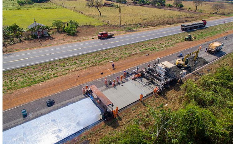
Figura 35 – Whitetopping, método de reabilitação de pavimentos asfálticos
