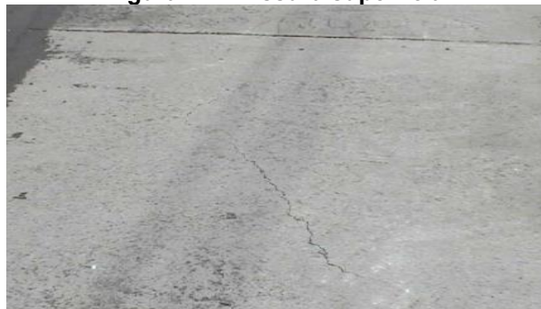
Figura 74 – Fissura superficial
