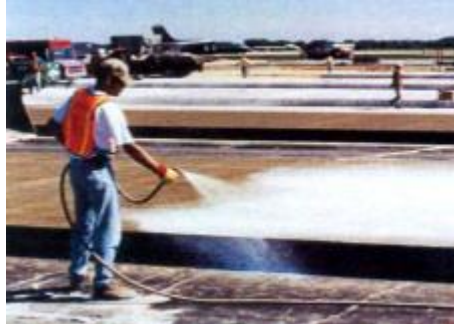
Figura 47 – Cura química realizada manualmente
