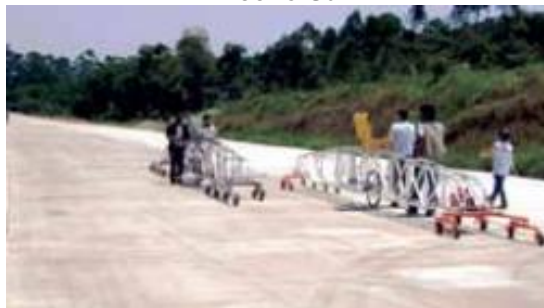
Figura 50 – Perfilógrafo Califórnia em operação no Rodoanel Metropolitano de São Paulo - Trecho Sul
