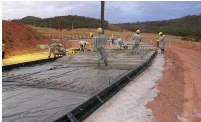
Figura 24 – Construção de revestimento em concreto feito com equipamentos simples e auxílio de formas fixas
