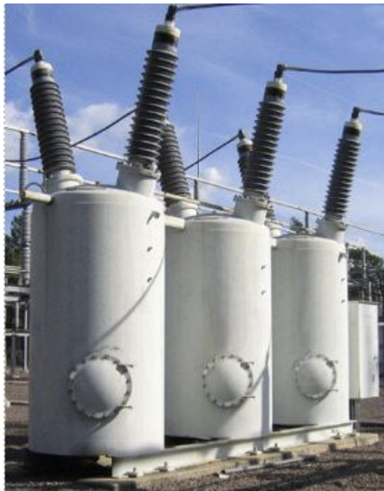
Figura 4 – Disjuntor GVO
