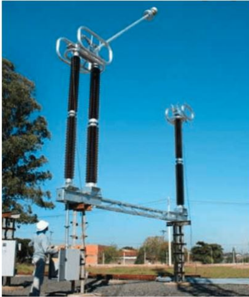
Figura 3 – Seccionadora da WEG
